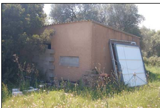
Bâtiment situé entre le cordon sableux et le marais
