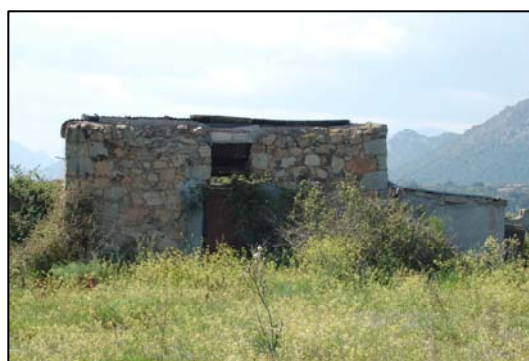
Ancien bâtiment agricole situé au sud du marais
