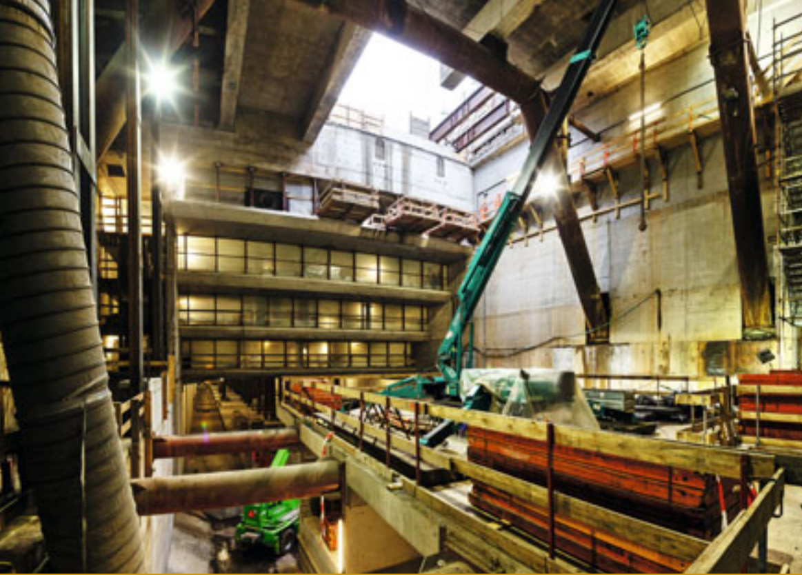
Temporäre Unterstützungen der Dachkonstruktion der Station Rokin
