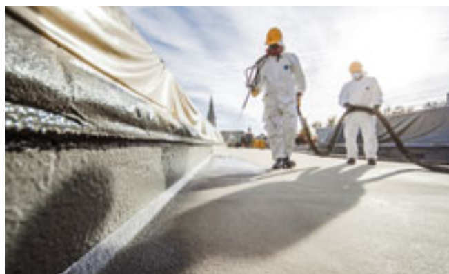
Aufbringen einer Flüssigkunststoffabdichtung im Spritzverfahren
