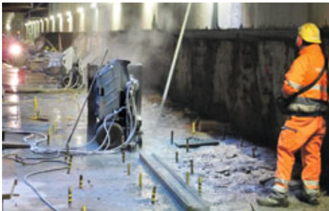
Seilsägearbeiten und Einbau architektonischer Gabelstempel in der Station Ceintuurbaan
