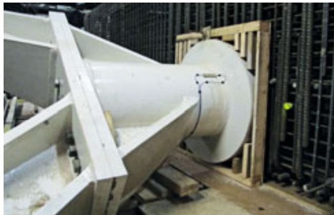
Seilsägearbeiten und Einbau architektonischer Gabelstempel in der Station Ceintuurbaan
