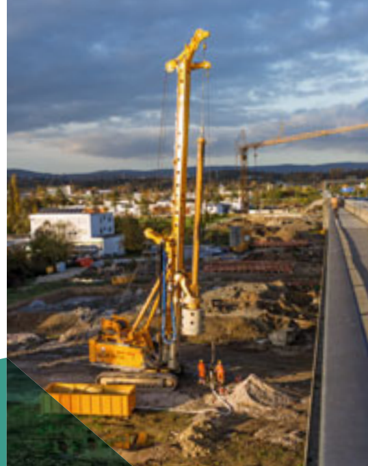
Für die sichere Gründung der Großforschungsanlage FAIR auf rund 1.400 Bohrpfählen sind bis zu fünf Drehbohrgeräte im Dauereinsatz.
