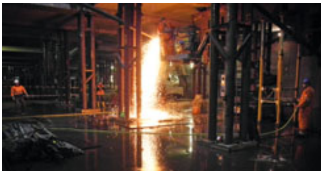
Stahlstützen ersetzen die bestehende Unterspannungskonstruktion an der Station Rokin
