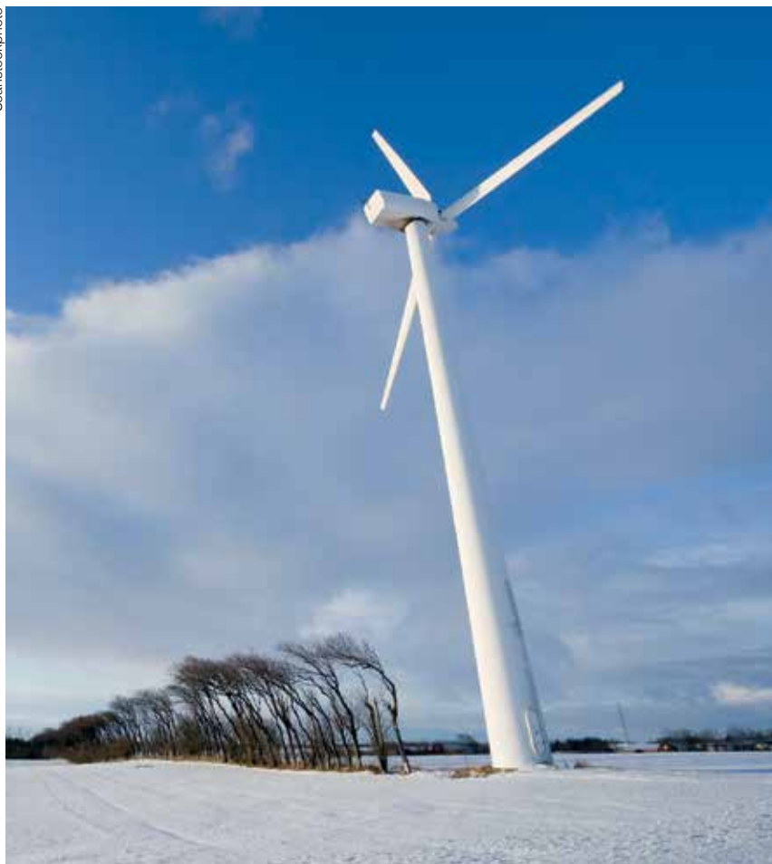
Suuren tuulivoimalan lapoihin voi kertyä vaarallisen paljon jäätä. Voimaloiden paikat on siksi harkittava tarkkaan.
