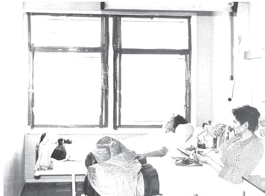
Od początku, tuż po montażu, wstawione okna były wadliwe. Trzeba było je uszczelniać taśmą klejącą, a nawet kocami.
