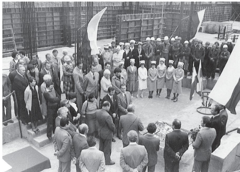
Uroczystość wmurowania aktu erekcyjnego, oprócz gości zebrali się pracownicy służby zdrowia i budowlancy.
