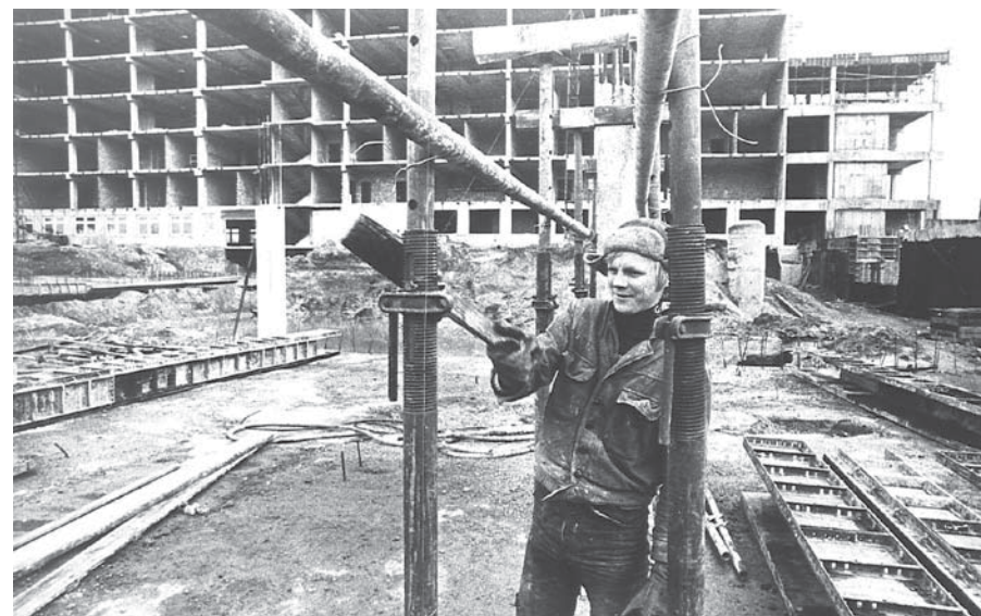
Początek lat 80. ubiegłego wieku. Budowa szpitala wojewódzkiego. Fot. Waldemar Sikorski
