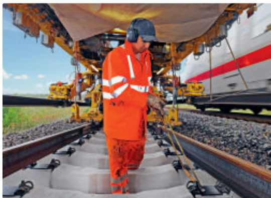
Während der Bauarbeiten im Ost-West-Korridor wird jeweils an einem Gleis gebaut, während das andere in Betrieb ist.
