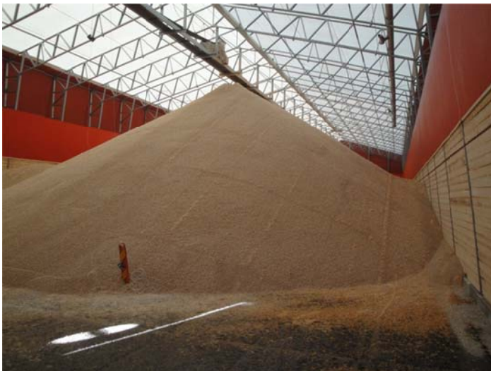
Bild 2 PVC-hall med träpellets.
