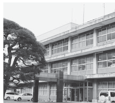
庁舎耐震補強工事は7月から開始予定
