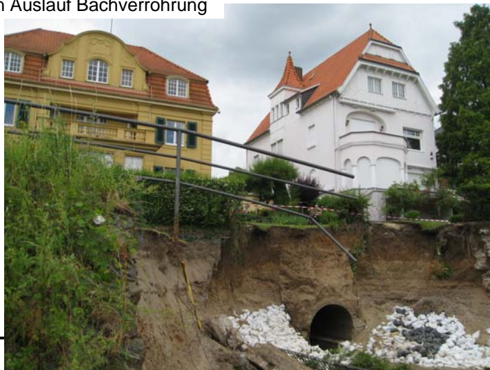
Situation Auslauf Bachverrohrung
