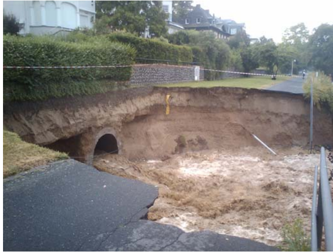
Stadt Bonn, Tiefbauamt 66-2 Dipl.-Ing. Daniel Koch Sachgebietsleiter Abwasserableitung und Gewässer
