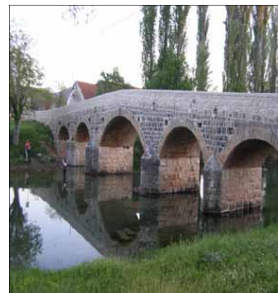
Slika 6. Most kraj sela Kaštel Žegarski (Ž. Drdar)
