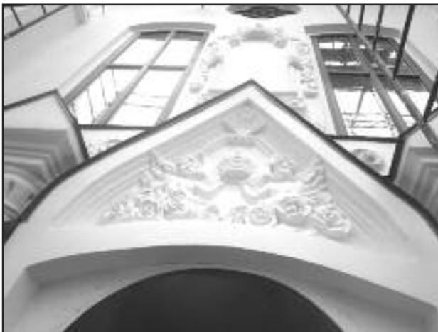
Троїцька церква в Китаєві. Північний фасад. Фрагмент. Фото автора. 2009 р.
