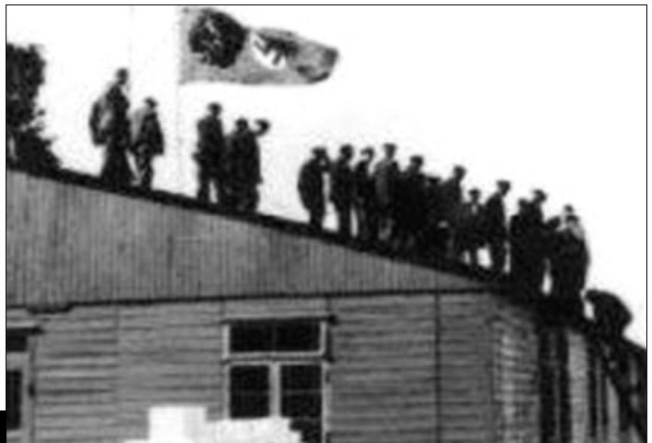
Richtfest des „Gemeinschaftslagers Ost“ der Ahlmann-Carlshütte am 20. August 1943. Foto: Landesarchiv Schleswig, Abt. 406.10, Nr. 2284.
