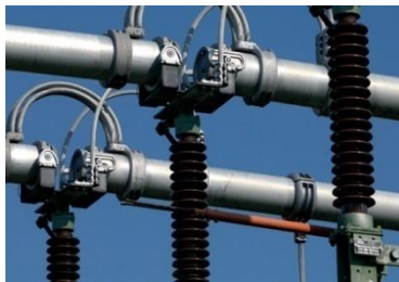
Planung und Bau von Energieversorgungsanlagen
