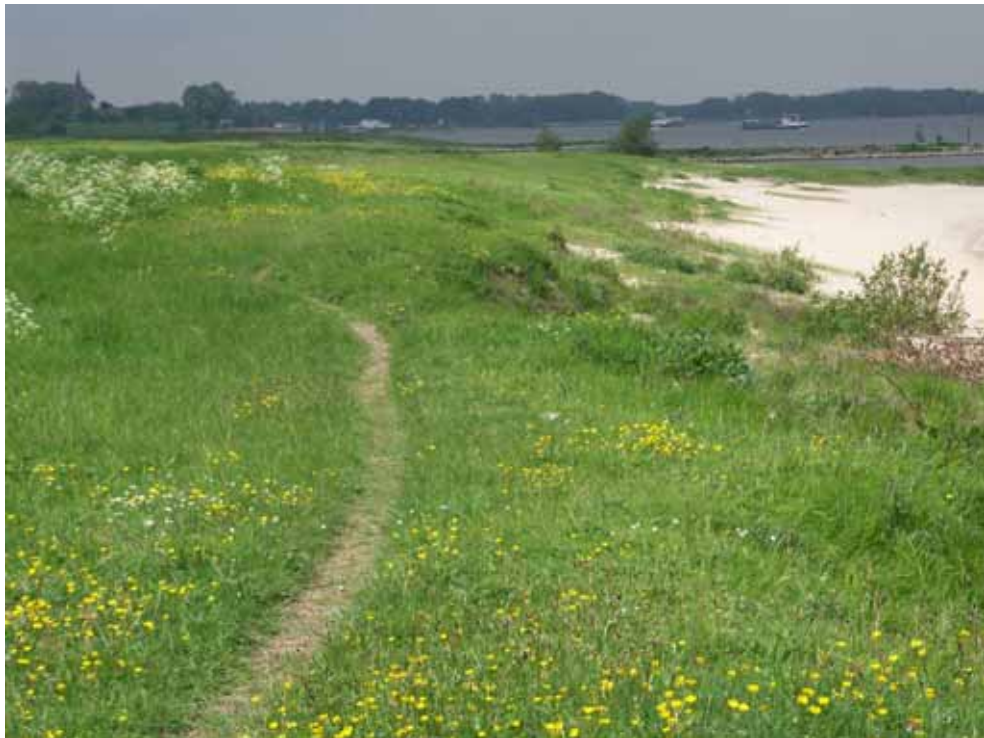
Overwal in de Breemwaard (foto Bart Peters).
