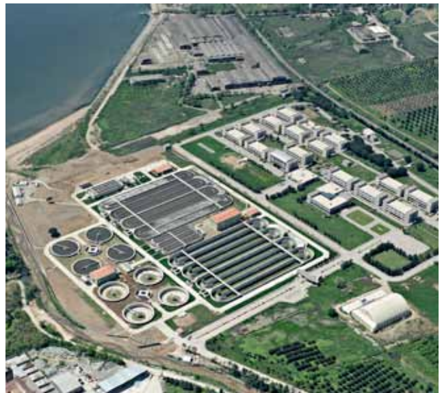
Kocaeli Gebze Atıksu Arıtma Tesisi
