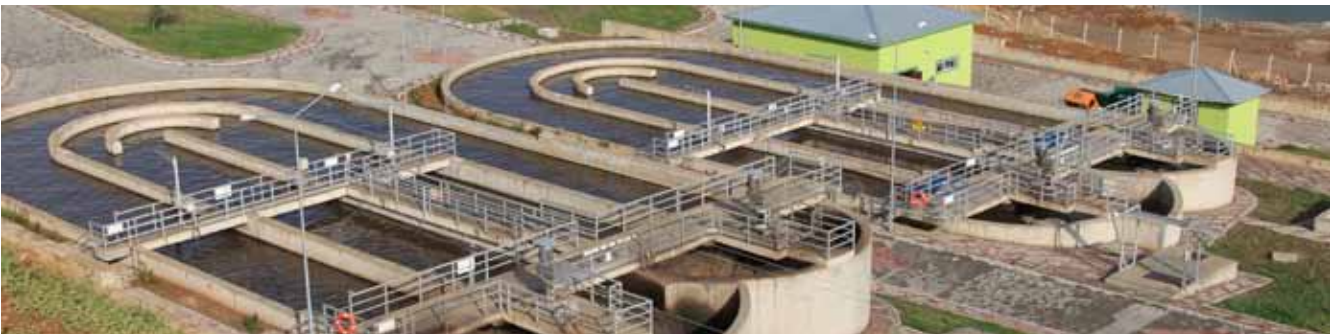
Tunceli Atıksu Arıtma Tesisi
