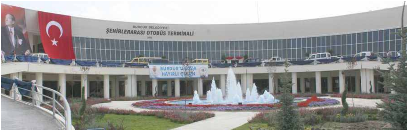
Burdur Şehirler arası Otobüs Terminali
