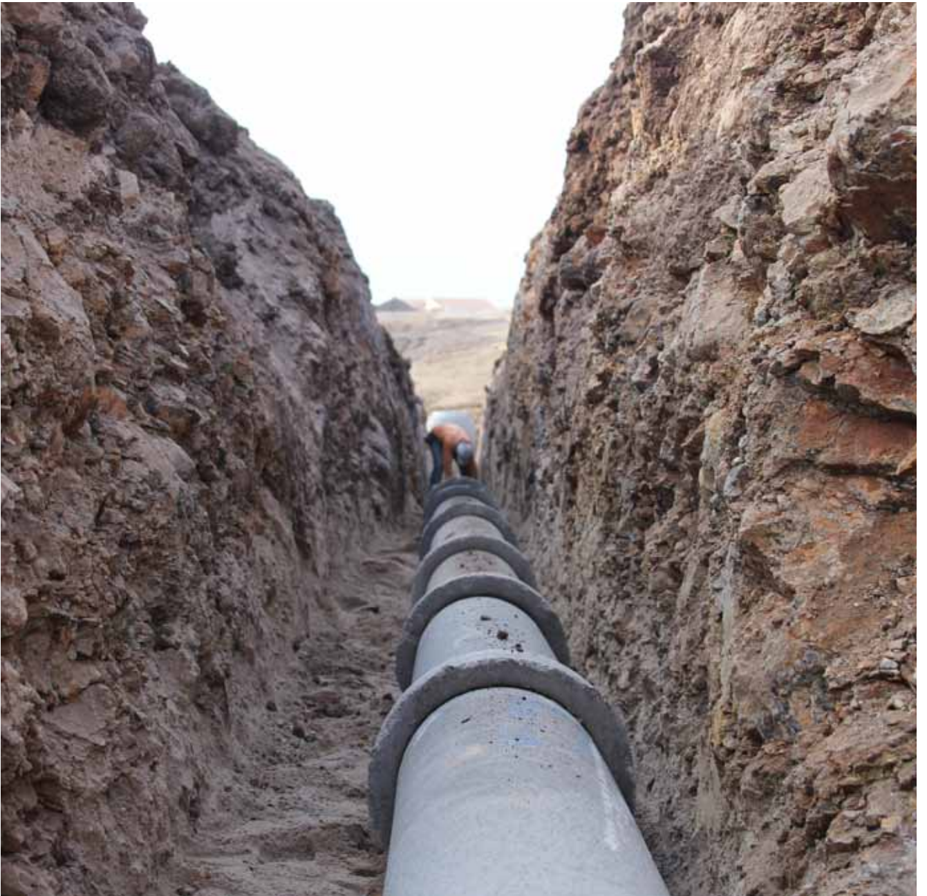
Elazığ Karakoçan İçmesuyu ve Kanalizasyon
