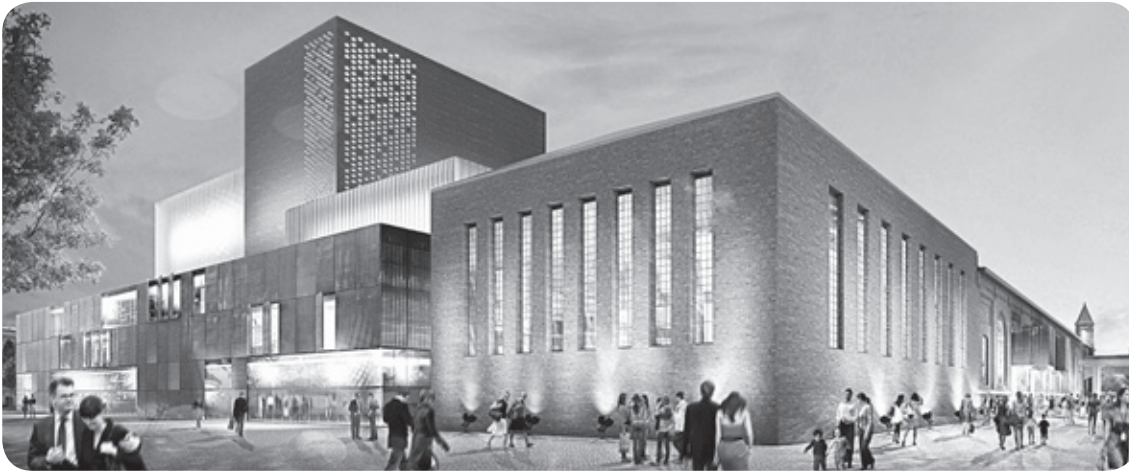
KKM Kraftwerk Mitte, Dresden
