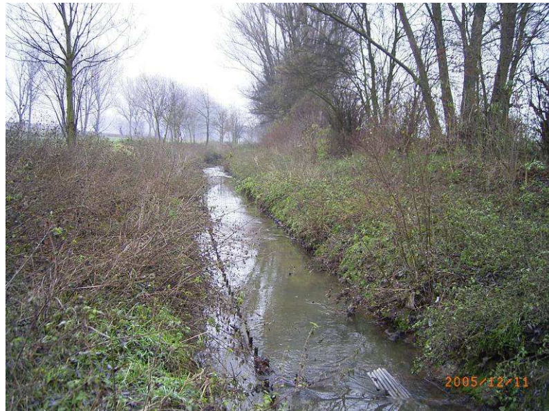
Abbildung 8 Selz unterhalb Bechtolsheim (Abschnitt 402), eingetieftes Regelprofil, Holzverbau linksseitig hinterspült
