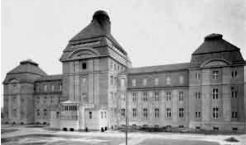
Die Anlage in Rudahammer wurde 1908 vom Oberschlesischen Knappschaftsverein zur Entlastung der großen Lazarette in Beuthen und Zabrze errichtet. Das Hauptkrankengebäude erhielt zur Sicherung gegen Bergschäden eine durchgehende stahlarmierte Betonplatte als Fundament. Wegen des abfallenden Grundstückgeländes wurden die Wirtschaftsgebäude teilweise zusammengefasst. Die Heizungsanlage war im Hauptkrankengebäude untergebracht. Das Lazarett konnte 310 Patienten aufnehmen.
