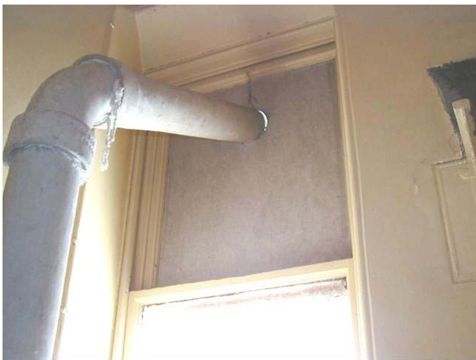
4.5. ábra Azbesztcement légakna, ahol az azbesztömítés azbesztpanelen keresztül fut. w.
