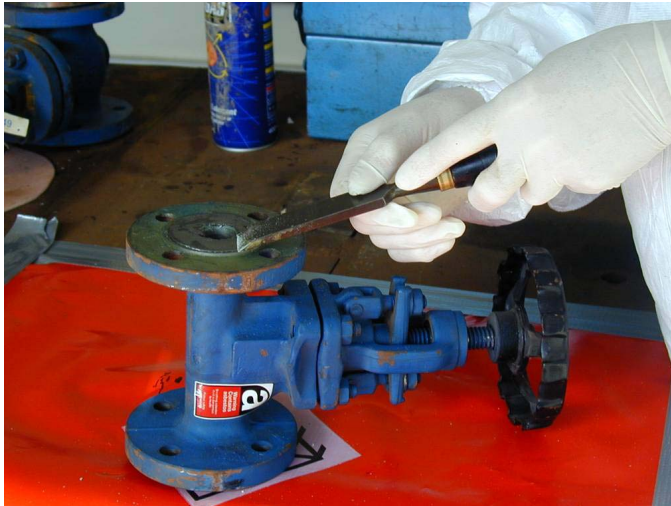
11.5. ábra Kézi szerszámok használata az azbesztömítésnek a szelepről történő leválasztása céljából.
