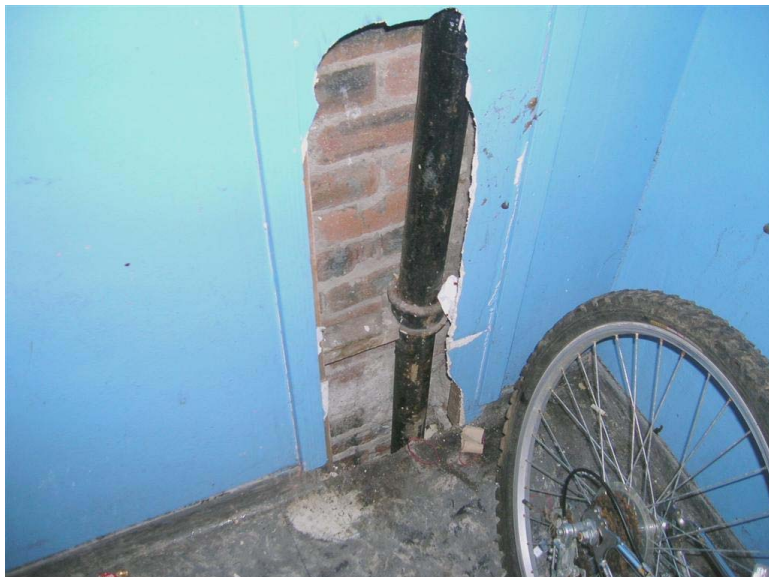
6.4. ábra Azbeszt szigetelőlemez; az eltávolítás során figyelni kell, mivel a lemez ezen a helyen könnyen megsérülhet
