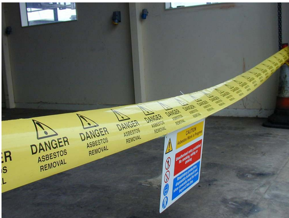
11.1. ábra Figyelmeztető szalagok és táblák használata egy terület elkerítése céljából
