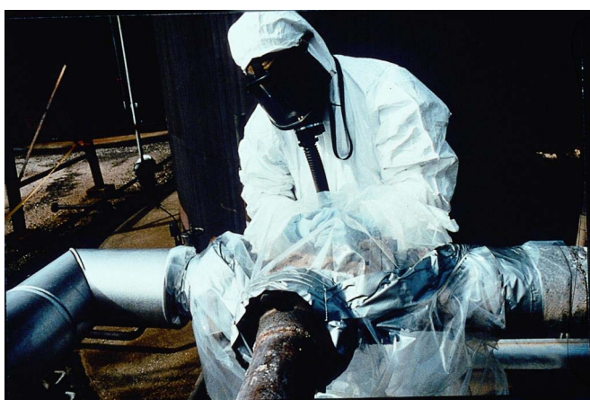
12.12. ábra Az azbesztbélés irányított azbesztmentesítésére használt kesztyűvel felszerelt zsákok (A fényképek az INRS-től származnak; szerzői jog: INRS)
