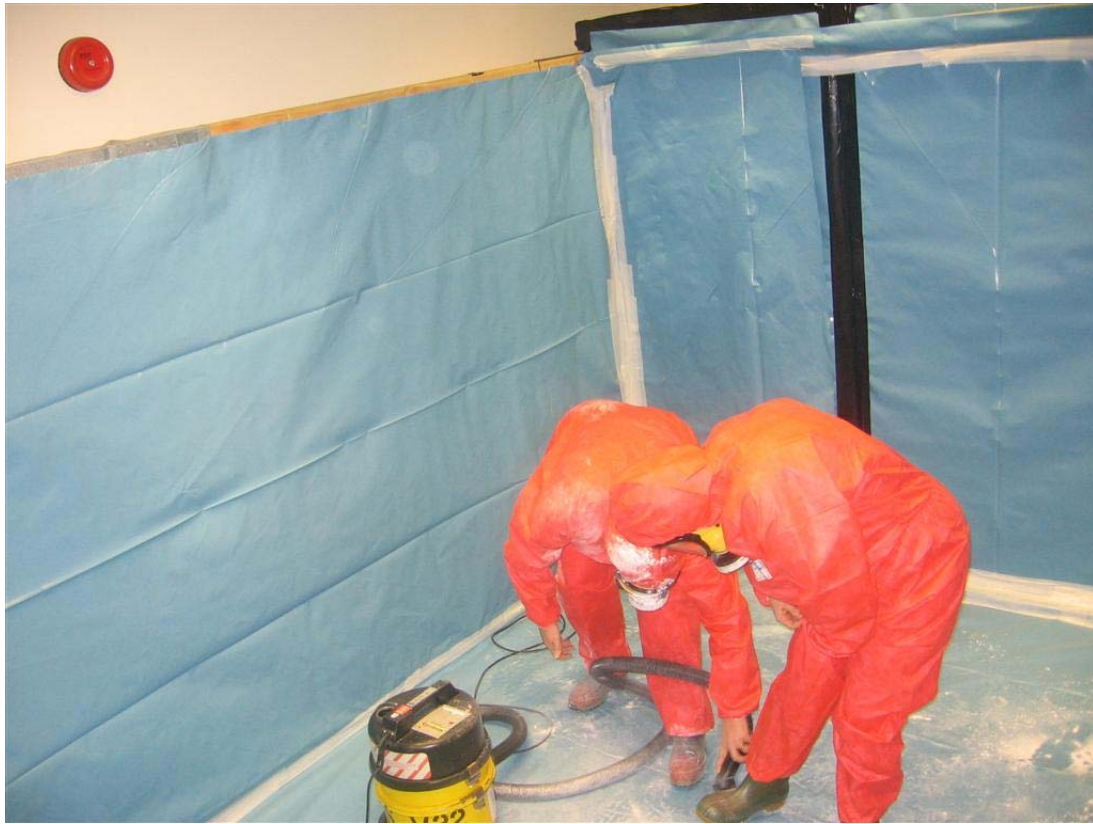
7.1. ábra Szimulációs gyakorlat, amely során vákumos H típusú porszívóval azbesztport (hintőpor) távolítanak el (az ábra az UK HSE-től származik)
