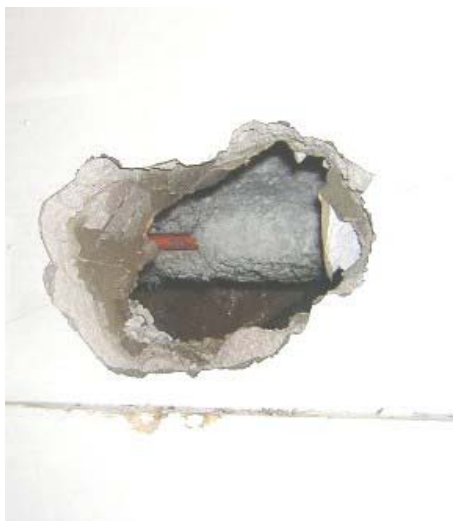
4.4. ábra Falban lévő azbeszt csőszigetelés.
