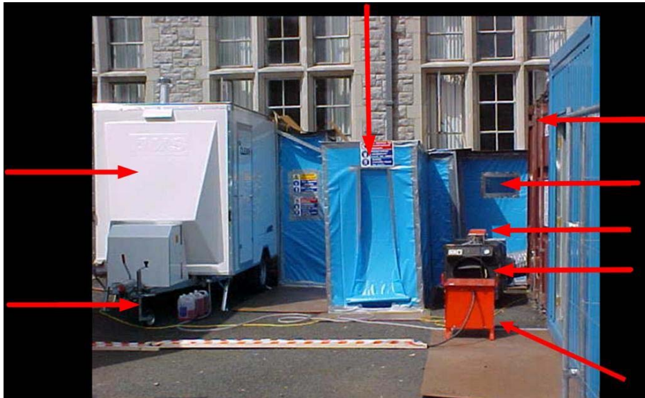
12.1. ábra Belépés egy zárt területre. A következő tárgyak láthatók a képen, felülről az óramutatóval megegyező irányban: zsilip, hulladéktartály, átlátszó panel, negatív nyomású mérőeszköz, negatív nyomású berendezés, áramellátó rendszer, nedvesítőszer-raktár és fertőtlenítőegység.
