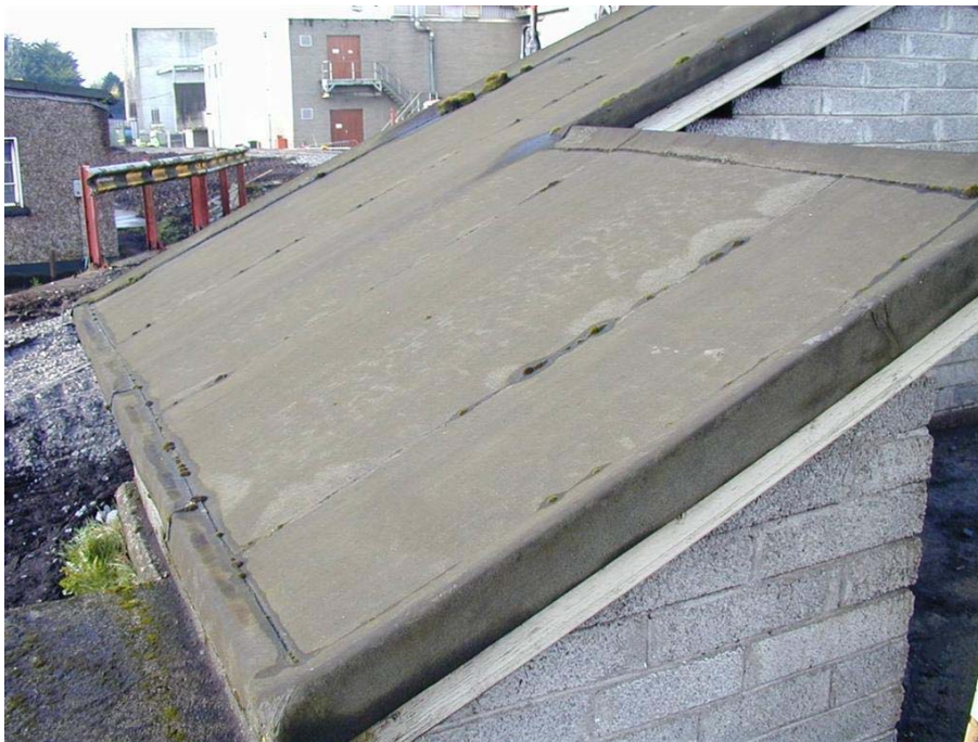
4.7. ábra Azbeszt tetőszigetelés
