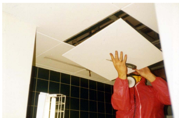
12.13. ábra Azbeszt szigetelőlemez óvatos eltávolítása.
