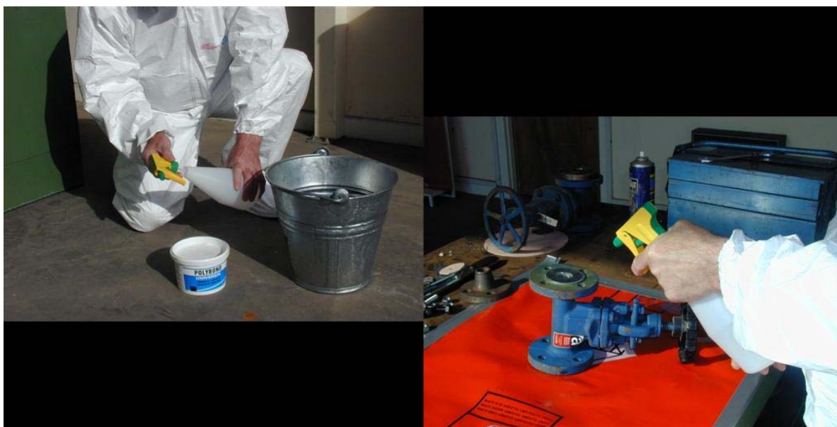
11.4. ábra Azbeszttömítés benedvesítése
