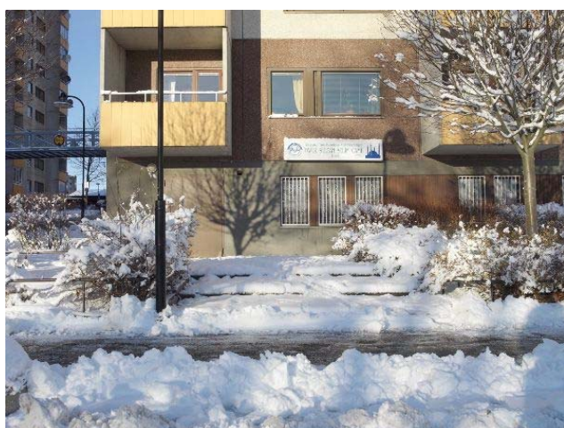
Fittja gamla moské vid Krögervägen. Skylten visar ändamålet. Källarkaraktern framträder genom olika fasadbehandling i källar- och bostadsvåningarna. Foto Mats Landin.
