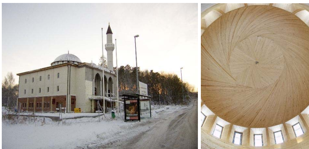
Fittja nybyggda moské vid Tegelbruksvägen. Kupolens träkonstruktion. Foto Mats Landin.
