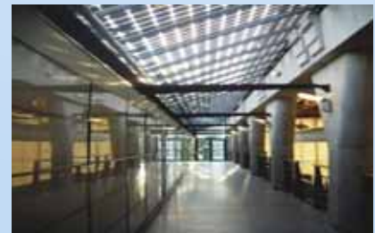
Wokingissa toimittilojen varautumista helleaaltoihin parannetaan rakentamalla varjostavia säleikköjä.
