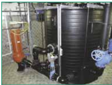
1 Tuuletus 2 Sulkukuula 3 Erotteluläpät 4 Sisääntulo 5 Jakelusäiliö 6 Poistoputki 7 Kokoomasäiliö 8 Kiinteän aineen erottelusäiliö
