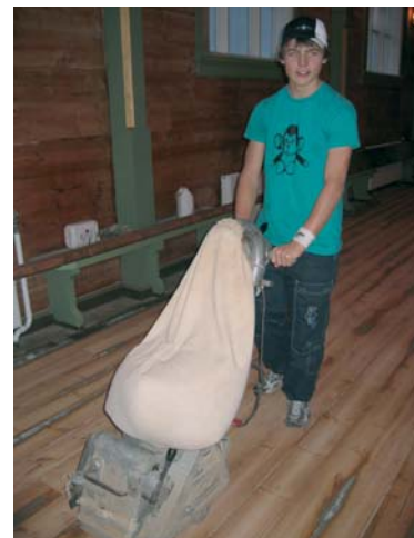
Golvet vert slipt ned og skal malast på ny. Kennet prøver slipemaskina til malarmeisteren.
