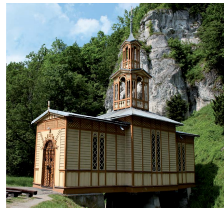
Kaplica Na Wodzie w Ojcowie, fot. M. Zaręba
