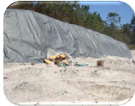
Relleno Sanitario de Santa Rosa
