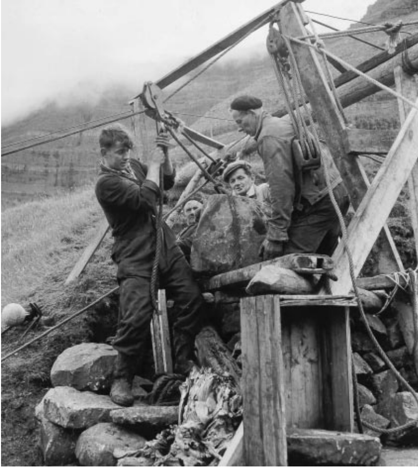
Fig. 3. Hejseapparatet monteres, 1961. Det færøske hus, som Bjarne Stoklund havde købt til Frilandsmuseet, lå på et meget utilgængeligt sted og det krævede både snilde og slid, at få det bugseret over i det skib, der skulle fragte det til København (foto i privateje).
