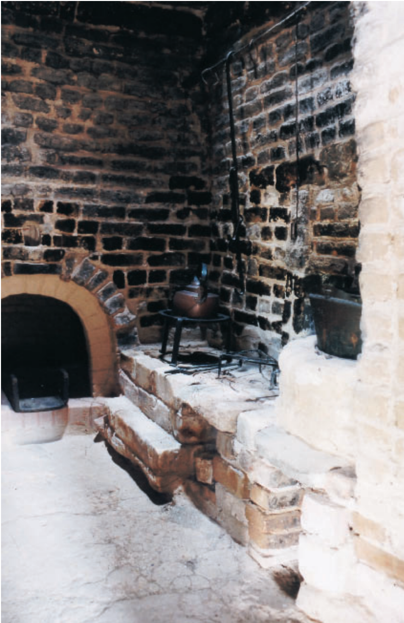
Fig. 2. Sparsomt indrettet køkken. Køkkenet var på sjællandske gårde placeret direkte i den store skorsten. På ildbænken ses bl.a. en ildtang og en trefod. Oven over hænger en grydekrog. Bagest ses indfyringen til bageovnen højere oppe. Varmen fra bilæggerovnen i stuen blev holdt ved lige fra køkkenet (location: Frilandsmuseet, Foto: Louise Mengers).
