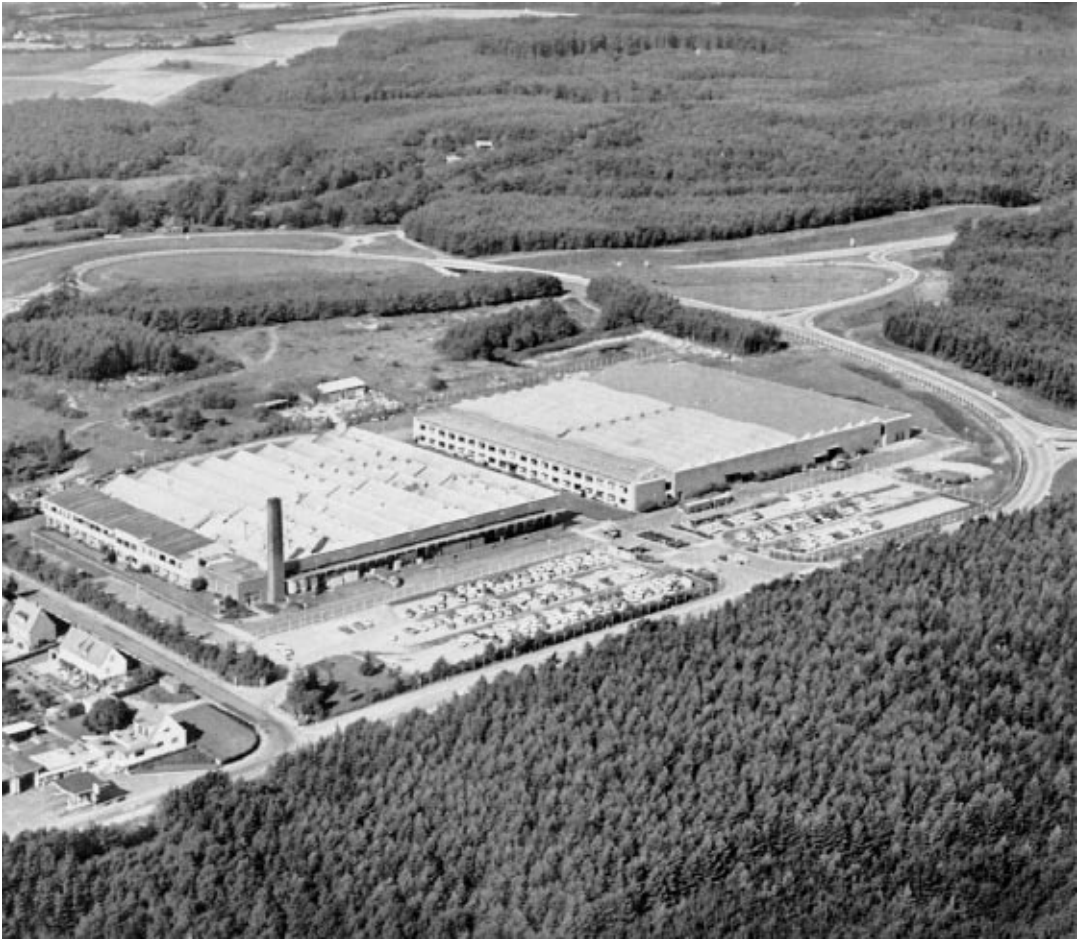
Fig. 3. Det industrielle landskab. Danfoss-filial ved Flensborg, et par km syd for den dansk-tyske grænse. I den organiske økonomis periode (før år 1800) ville et landskab som dette være utænkeligt. Da lagde man ganske vist også produktionsanlæg midt i skovområder, men det var for at få brændsel, og anlægget bestod i reglen kortere end de optimistiske igangsættere håbede. Et glasværk eller et mindre jernudsmeltningsanlæg kunne rasere et mægtigt skovområde på få år. I den fossile økonomi, hvor landskabets ressourcer ikke længere indgår som produktionsfaktorer, og hvor den geografiske placering derfor er tilfældig eller bestemt af rent sekundære hensyn, f.eks. æstetiske eller – som her – toldbarrieren mellem Tyskland og Danmark i 1950'erne, kan fabrikker ligge midt i en skov, uden at der fældes et træ (Foto: Danfoss, ca. 1960).
