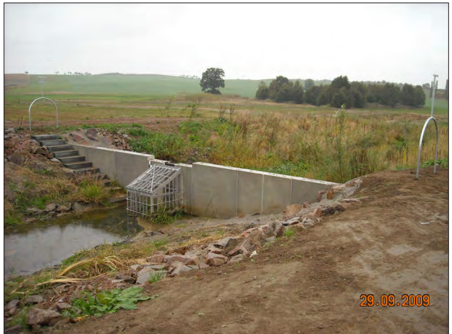
Abb. 20: Hochwasserrückhaltebecken Schullwitzbach (Flutmulden), Drosselbauwerk
