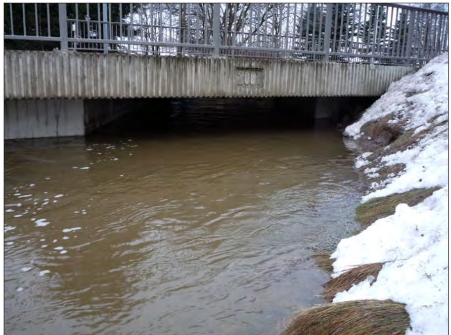
Abb. 31: Brücke Dittersbacher Straße, Februar 2009
