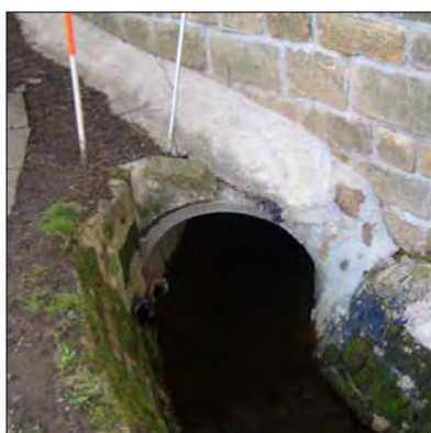
Abb. 30: Einlauf Verrohrung unter der Alten Schmiede
