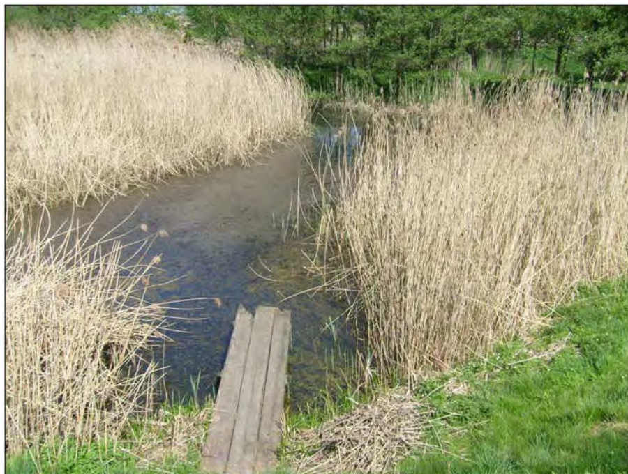
Abb. 21: Regenrückhaltebecken 96W8 "Aspichring" am Aspichbach
