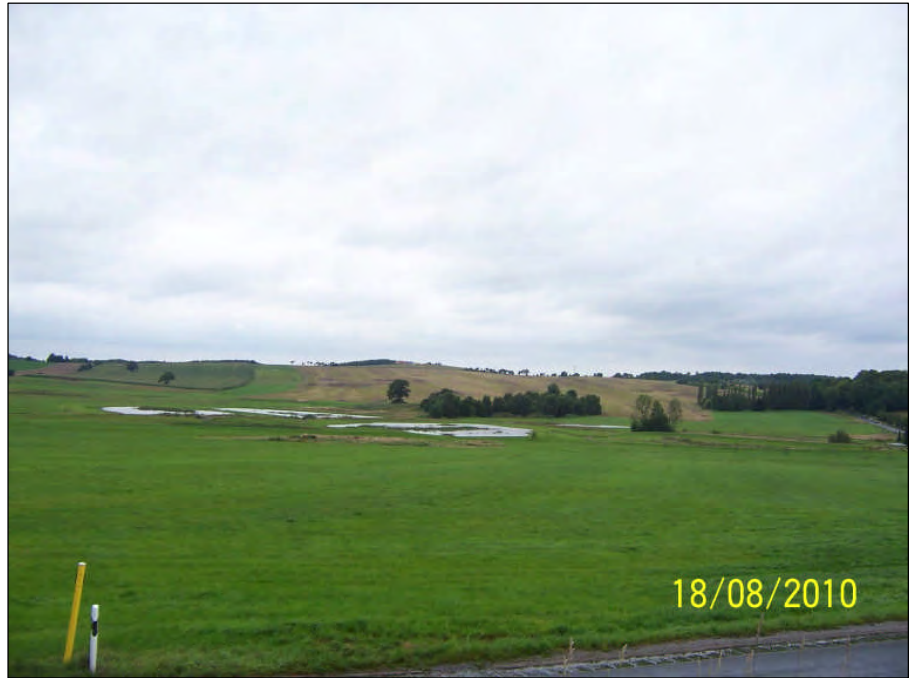
Abb. 19: Eingestautes Hochwasserrückhaltebecken Schullwitzbach (Flutmulden)
