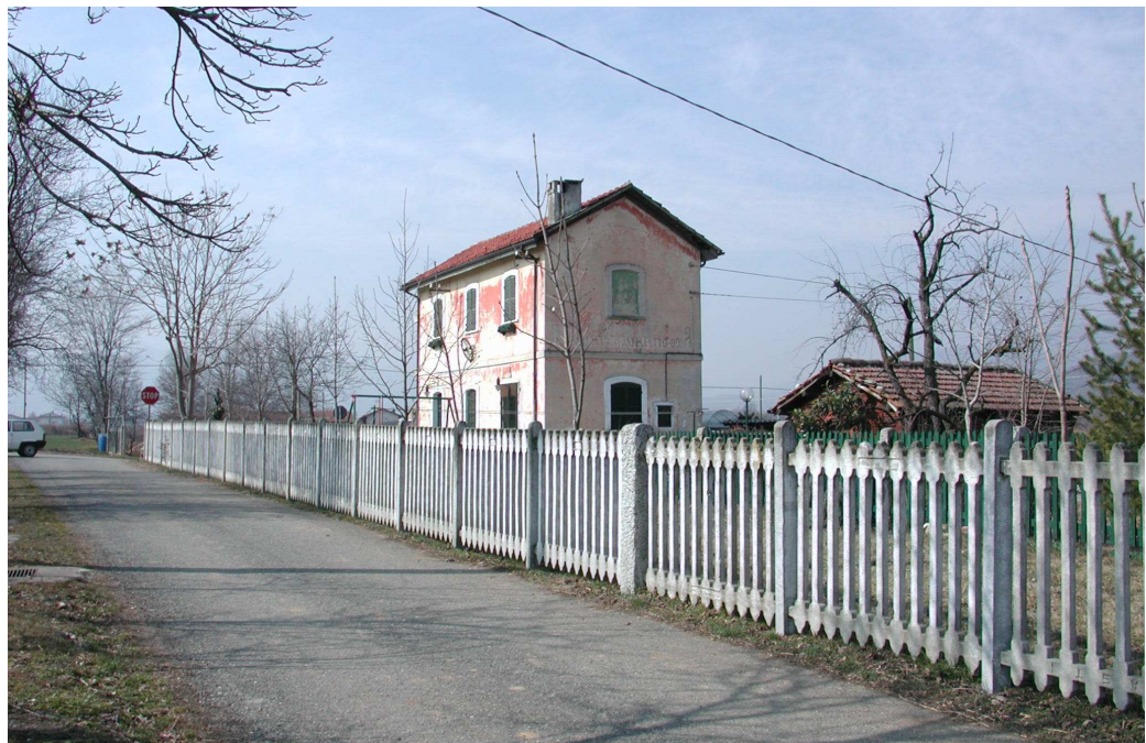
FIGURA 16: Fabbricato Viaggiatori ed ex fabbricato W.C
