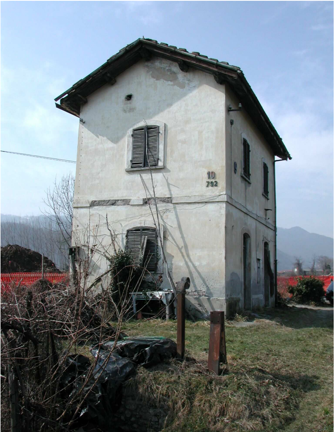
FIGURA 30 : Casa Cantoniera al km 10+792
