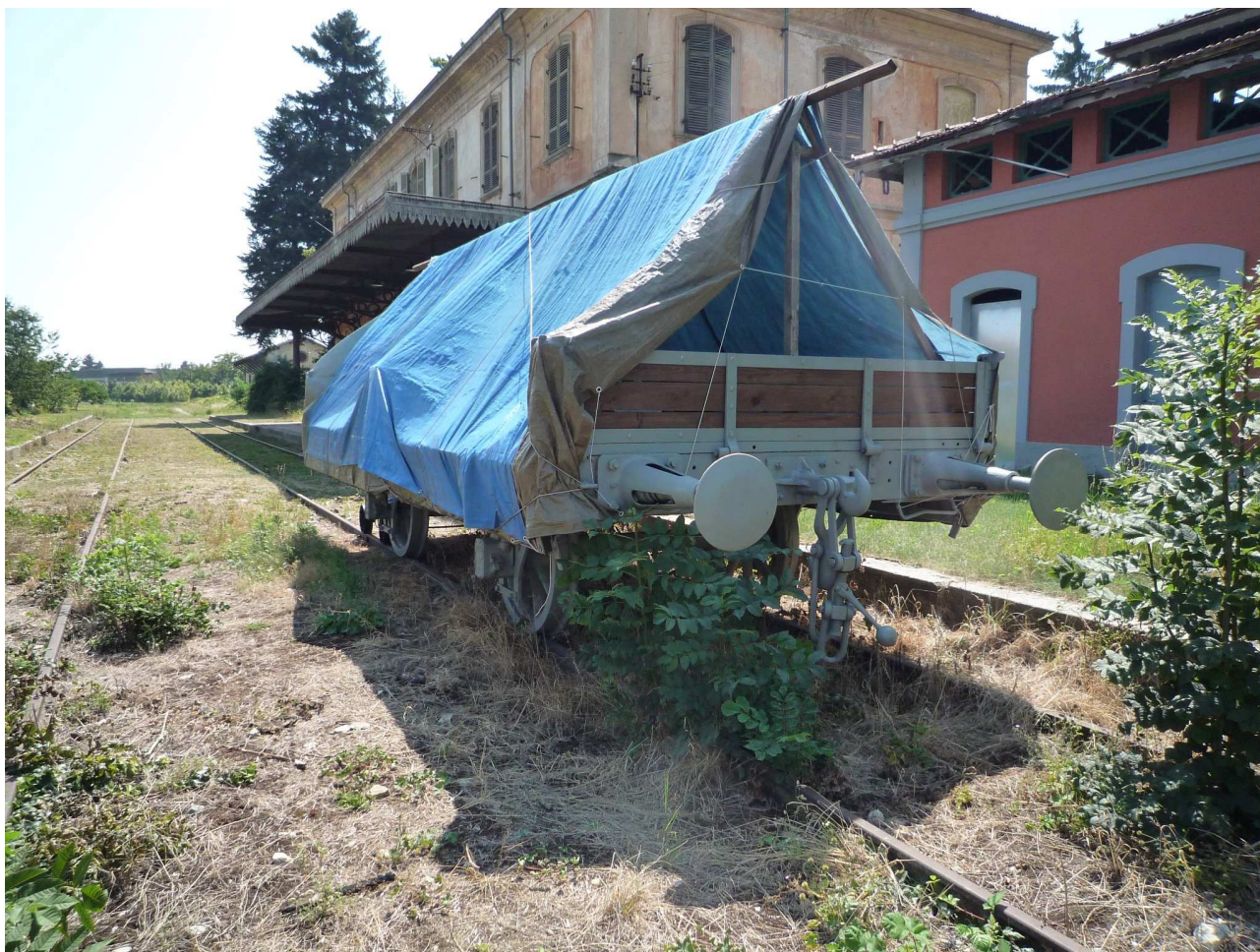
FIGURA 34 : Fabbricato Viaggiatori e fabbricato W.C.
