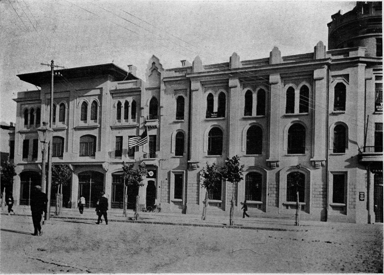
Konsoloshane binası ve Roma bankasının bir kısmı.
