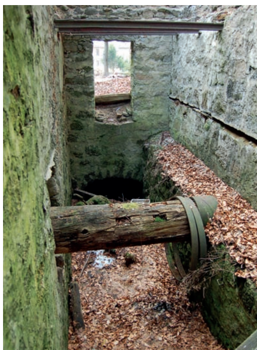
Obr. 8_Lednice s hřideli vodního kola, březen 2011 Foto M. Kolka
