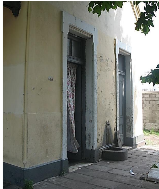
Accesos desde el exterior a áreas de servicio del edificio
