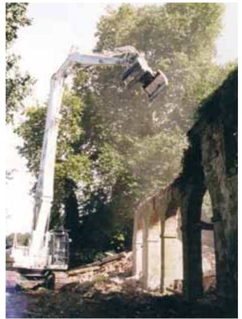
1J/757 - Démolition du château de Bellejame @ J. Cartier
