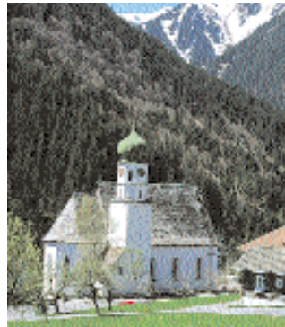
Außenansicht der Pfarrkirche St. Gallus in Gallenkirch
