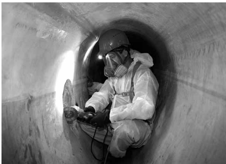
Freilegen der Hausanschlüsse an das sanierte Kanalprofil.
