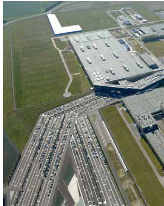
Das BMW-Werk in Leipzig wird gegenwärtig um ein Presswerk und ein Fertigungsgebäude für den Karosseriebau erweitert. Neben 3er Limousine und drei Varianten der 1er Reihe soll künftig auch der neue X1 aus Sachsen kommen.
