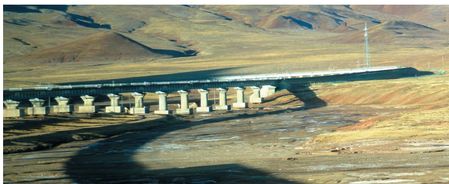
>>> Эстакада на высокогорье
