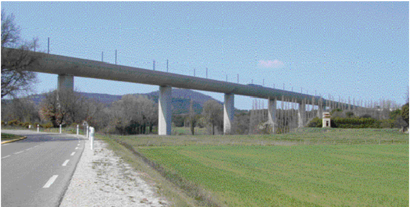
Le viaduc de la ligne du TGV franchit la plaine de Cazan à Château-Bas
