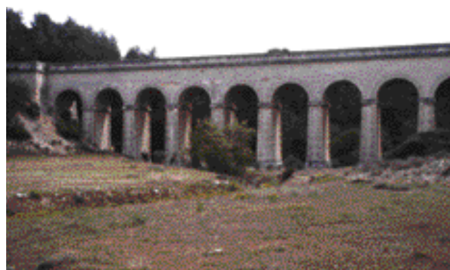
Aqueduc du canal de la Durance dans le vallon de la Valbonnette
