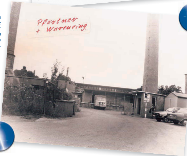
Die damalige Ist-Situation vor der Übernahme der "Halle Saline" mit Originalvermerken des damaligen Geschäftsführers Jürgen Krahnfeld.
