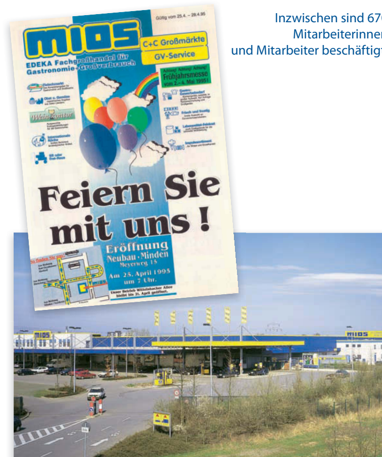
Der Neubau in Minden am Meyerweg 15
