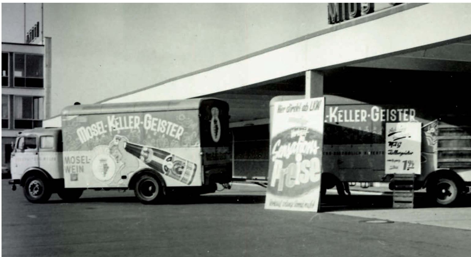
Außenansicht der MIOS Minden Ende der 1960er/ Anfang der 1970er Jahre. Im Hintergrund ist das Verwaltungsgebäude der EDEKA zu sehen.
