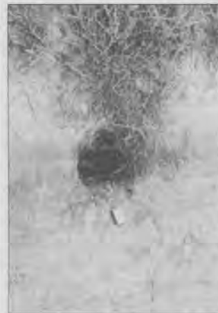
Víznyelő a Maros jobb parti védtöltésén (Bíró Ferenc felvételei)
