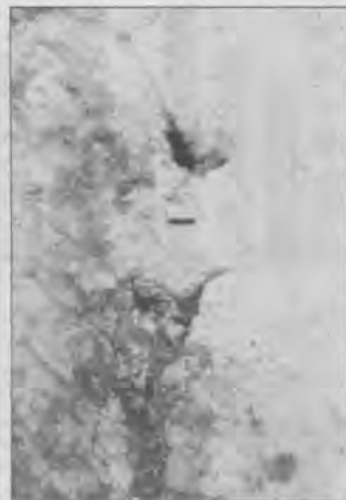
Repedések a Maros jobb parti töltéskoronáján
