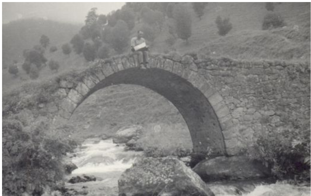
Кəlbəcər ərazisində Xaçın çayı üzərində körpü
