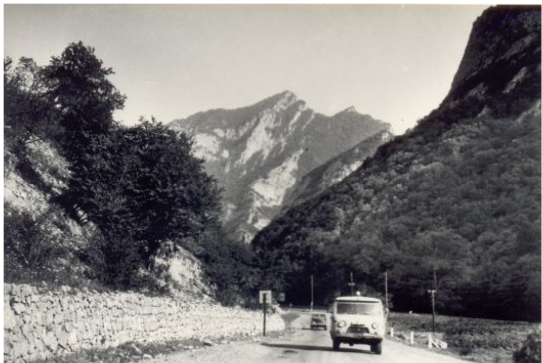
Tərtər - Kəlbəcər avtomobil yolu, Nadirxanlı kəndinin giriş hissəsi
