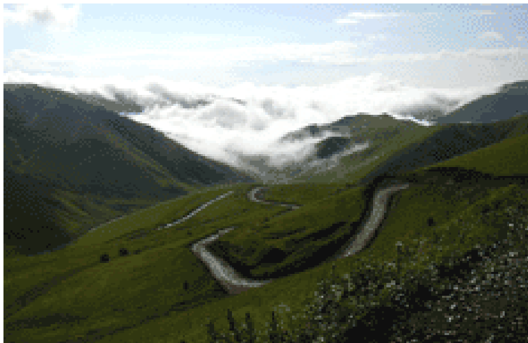
Murov dağı ilə Kəlbəcər - Xanlar avtomobil yolu
