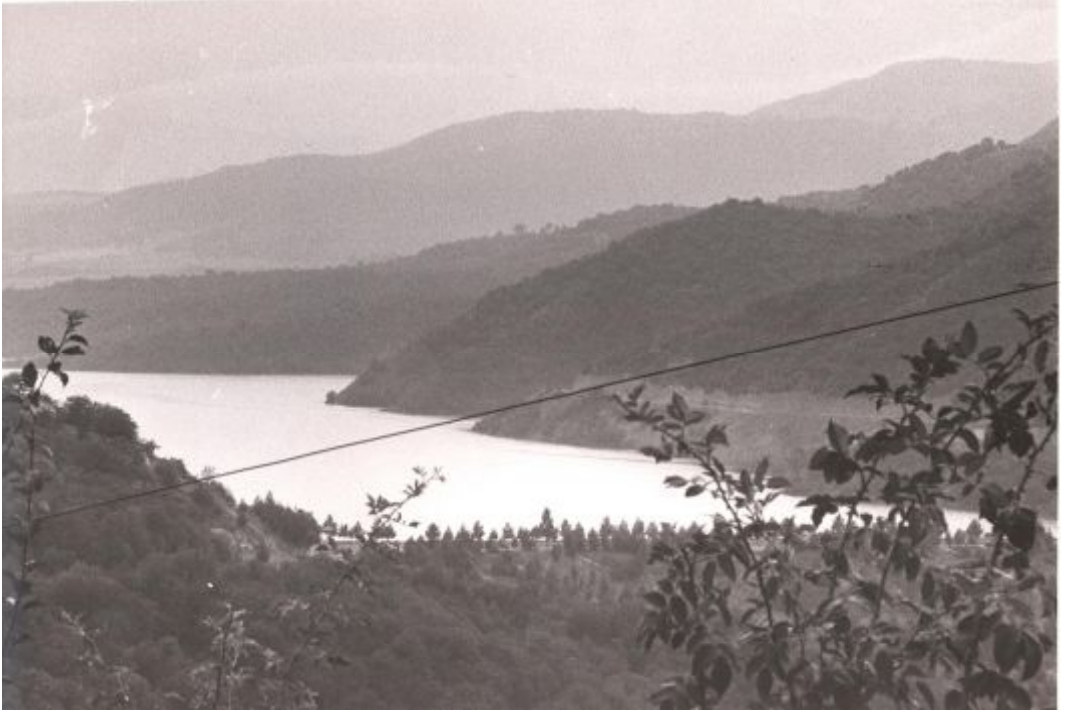
Tərtər çayı üzərində Sərsəng SES (su elektrik stansiyası)
