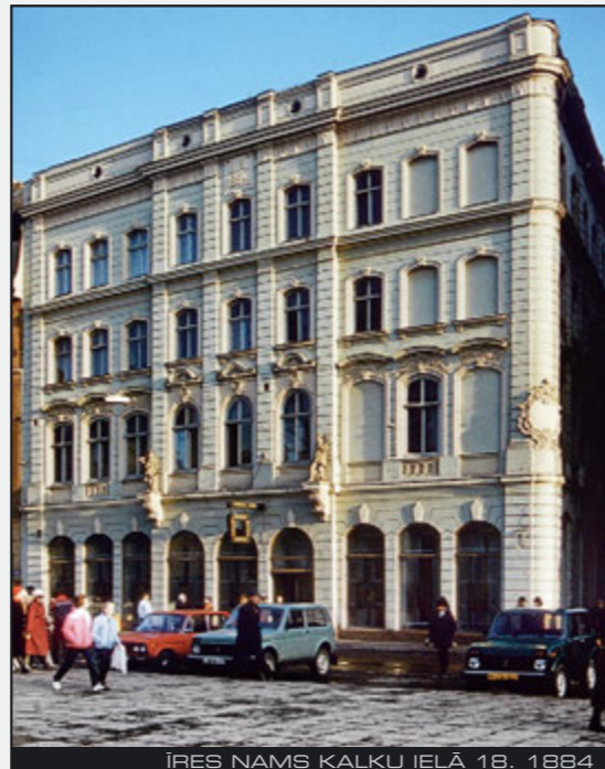
IRES NAMS KAĻĶU IELĀ 18. 1884
