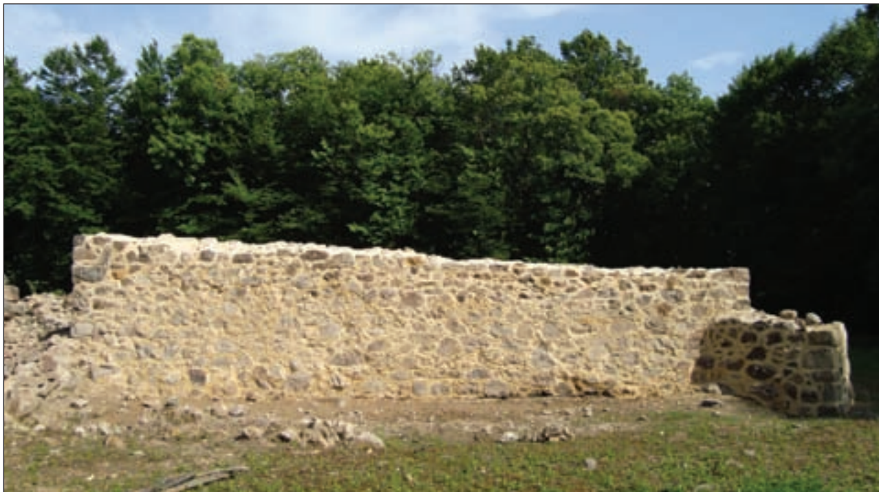
Pogled na sjeverni zid samostanske crkve sv. Petra nakon konzerviranja (foto: T. Pleše)
