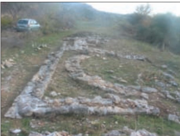
Otres, srednjovjekovne kuće tijekom sanacije (foto: M. Zekan)
