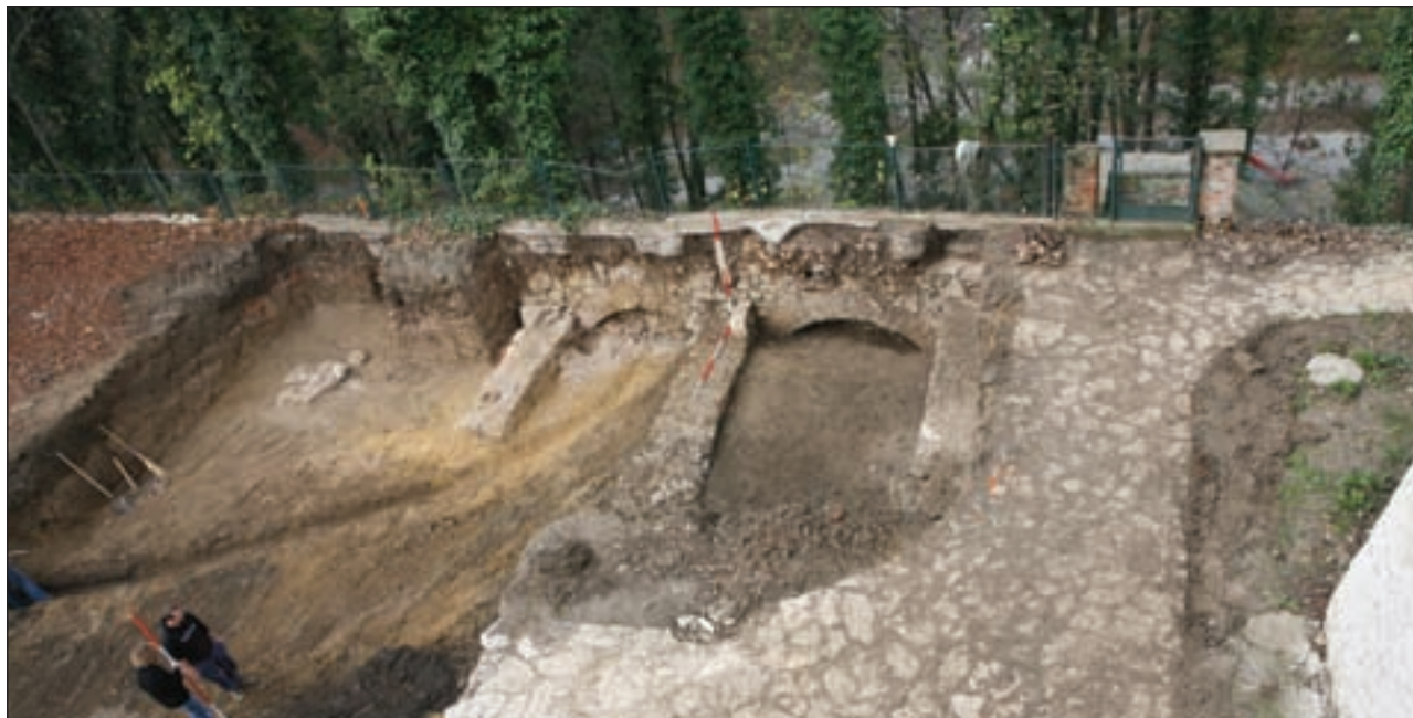
Posebno atraktivan nalaz zbog načina izrade jesu podzid i istodobno sidrenje terena, potkraj 18. st.
