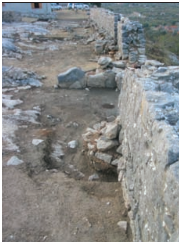
Bribir, situacija u tijeku radova
