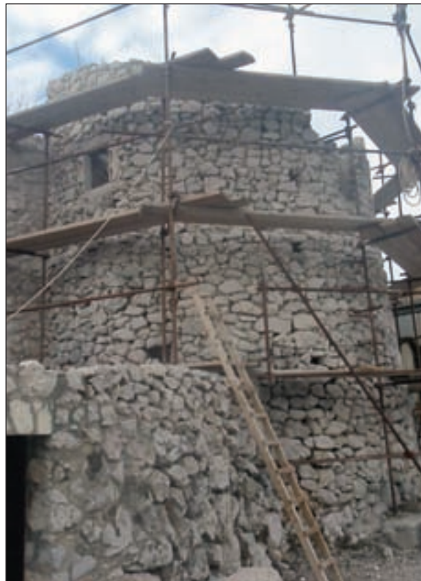
Pogled na polukulu Keštel tijekom radova
