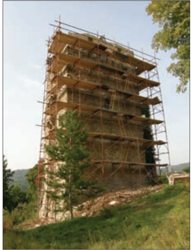
Pogled na sjeverni zid kule prilikom građevinske sanacije (foto: J. Višnjić)
