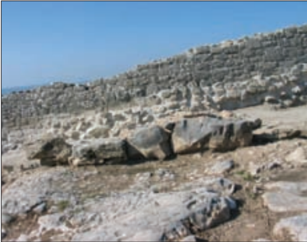
Bribir, sanacija zida
