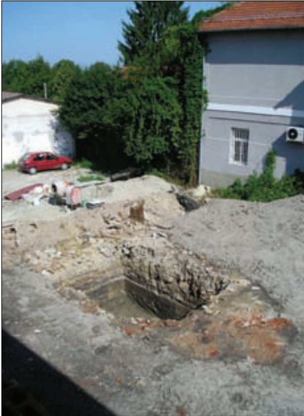
Dvorište u Ulici P. Zrinskog 3; iskop za septičku jamu (foto: M. Šimek)
