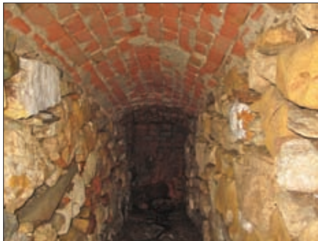
Glavni kanal za odvodnju sanitarnih i oborinskih voda izgrađen od kamenih zidova i bačvasto nadsvođen opekom
