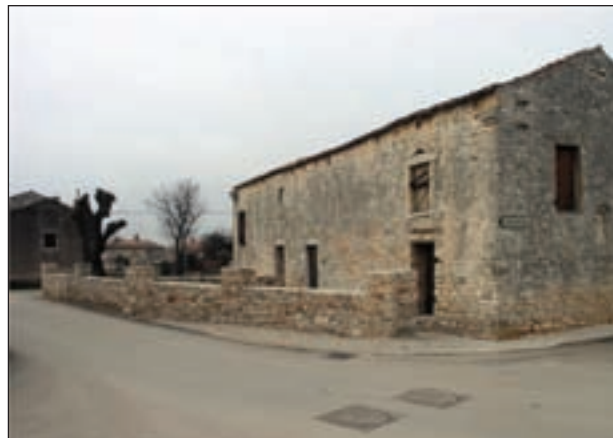
Novi ogradni zid uz crkvu sv. Stjepana (foto: A. Milošević)
