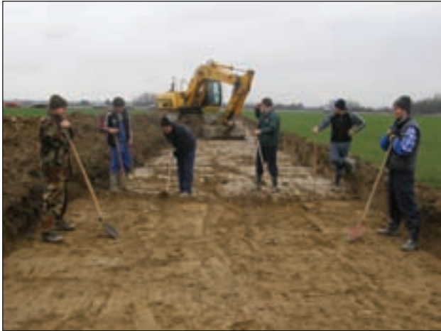
Poliranje trase plinovoda na nalazištu Kućanci – Ravne (foto: I. Pleština)
