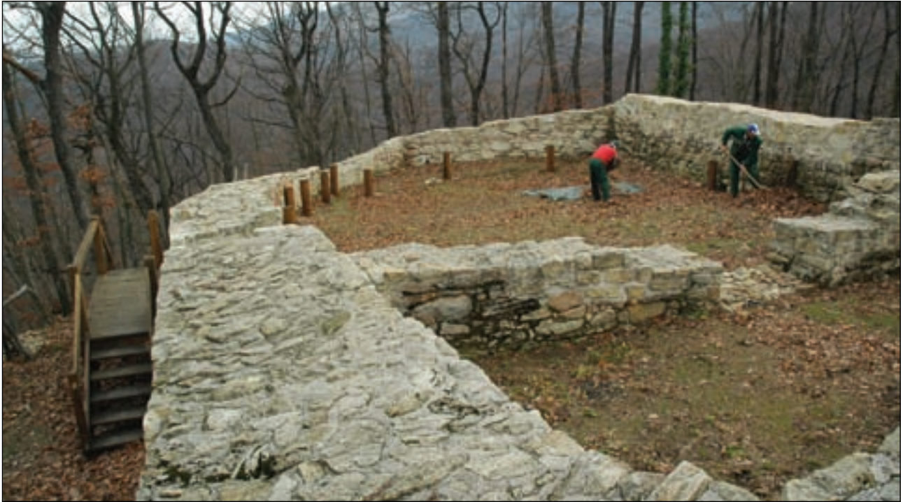
Čišćenje unutrašnjeg dijela objekta; postavljena je ulazna konstrukcija (foto: M. Šimek)
