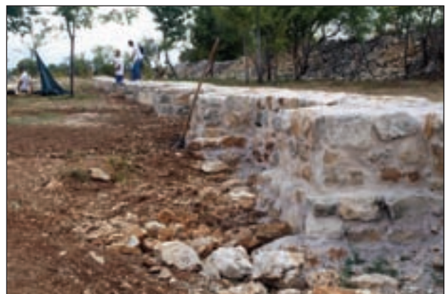
Sjeverni perimetralni zid kampusa u Burnumu
