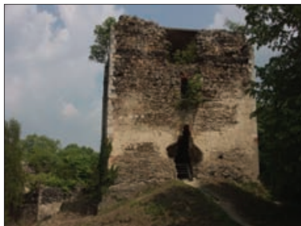
Pogled s juga na središnju kulu prije početka pripremnih radova (foto: T. Pleše)
