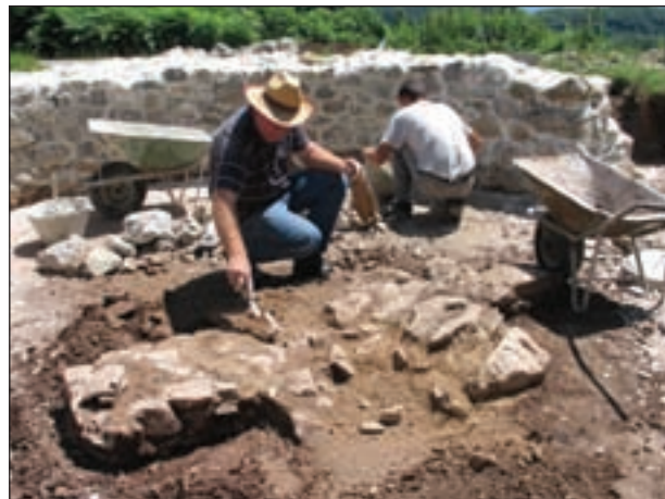
Budinjak – kapela svete Petke, čišćenje i razgradnja oslabljenih dijelova temelja na ulazu u istočnu apsidu (foto: M. Želle)
