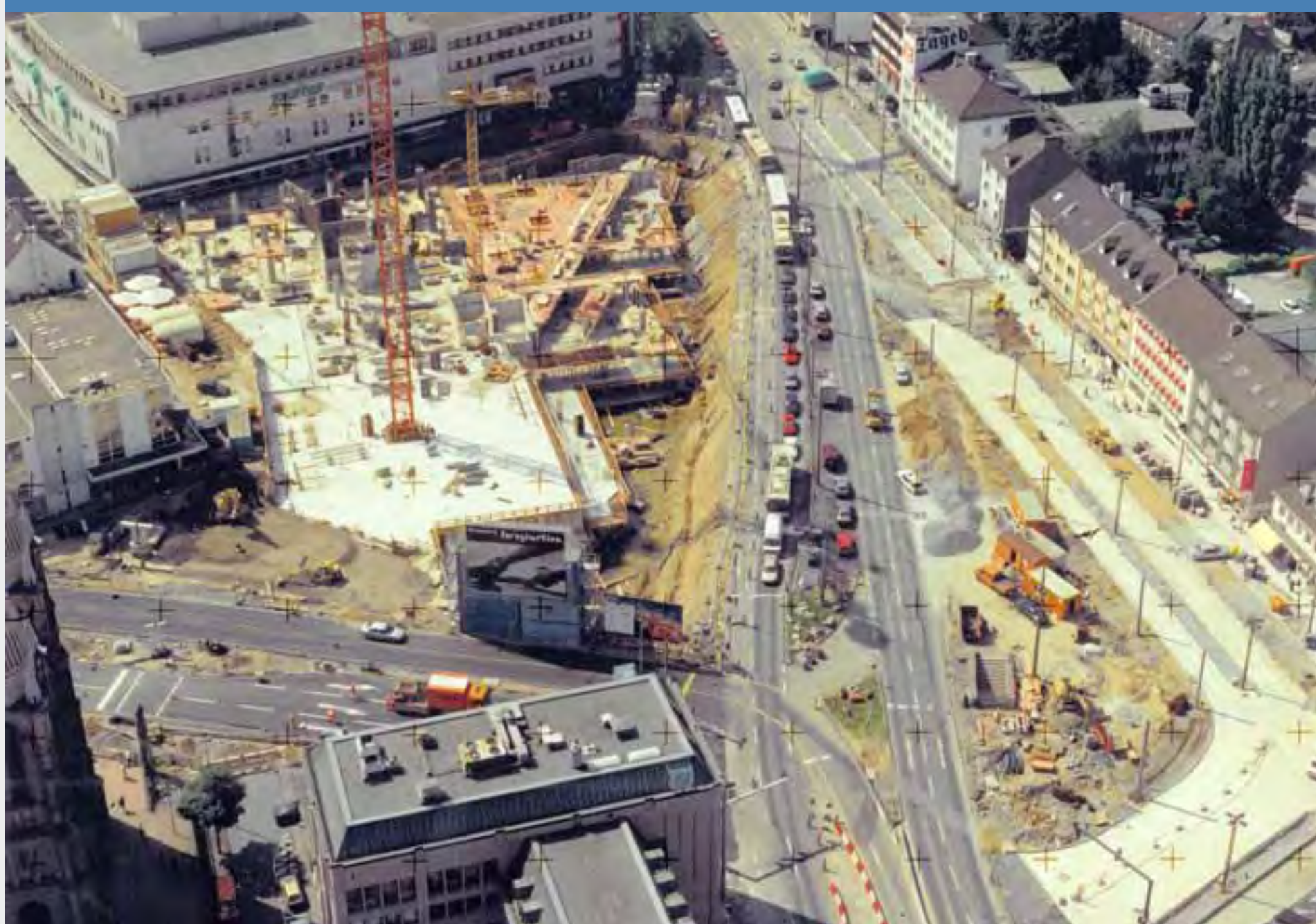
Während der Amtszeit von Ulrich Uibel veränderte die Solinger Innenstadt ihr Angesicht unübersehbar. Im September 1997 begannen die ersten Arbeiten für die Tiefgarage, am 4. Februar 1998 fiel der offizielle Startschuss für den Baubeginn an Solingens „neuer Mitte“.
