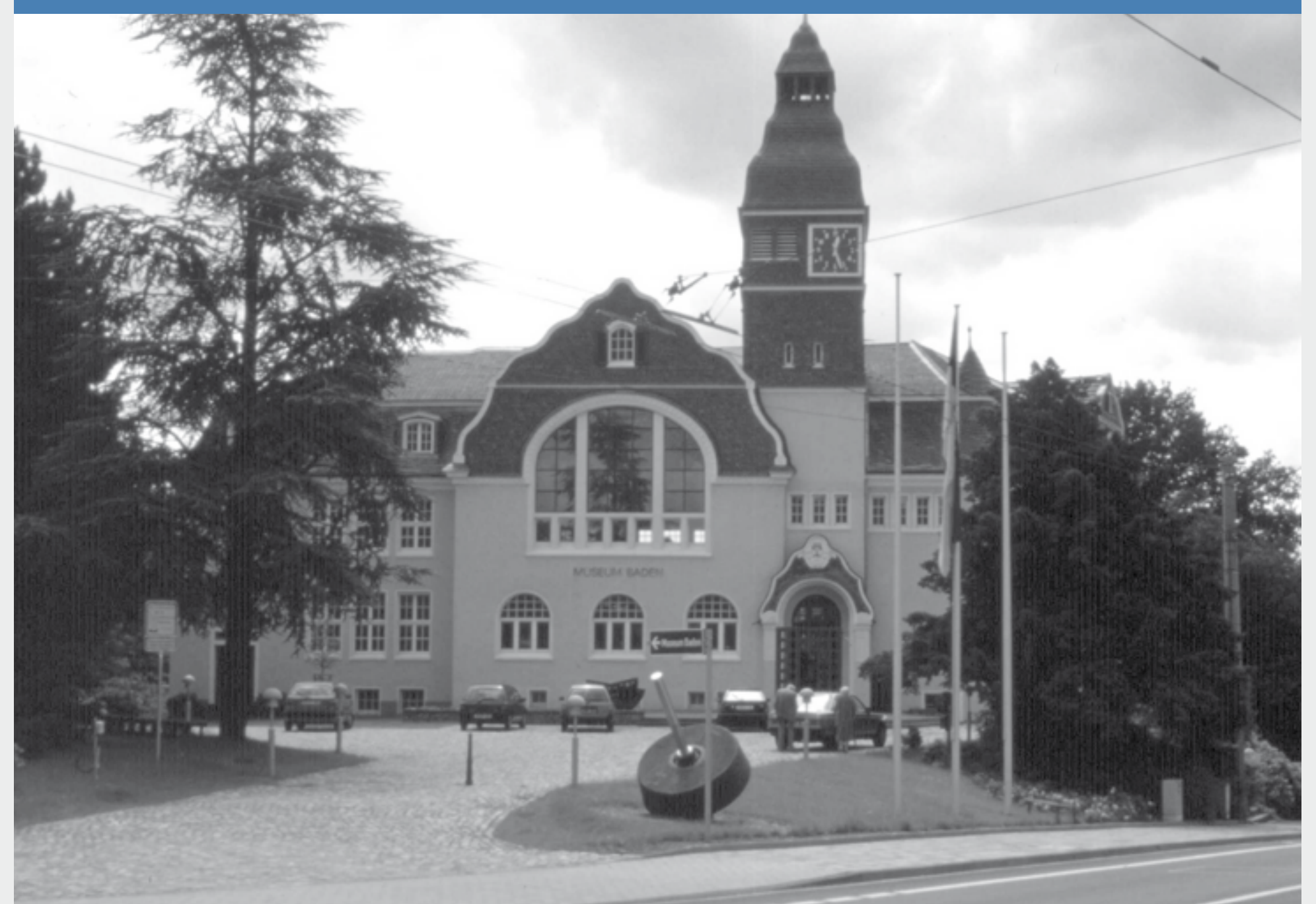
Nach umfangreichen Sanierungs- und Umbauarbeiten am ehemaligen Gräfrather Rathaus und Deutschen Klingensmuseum konnte am 27. Oktober 1996 dort das Kunst-Museum Baden der Öffentlichkeit übergeben werden.
