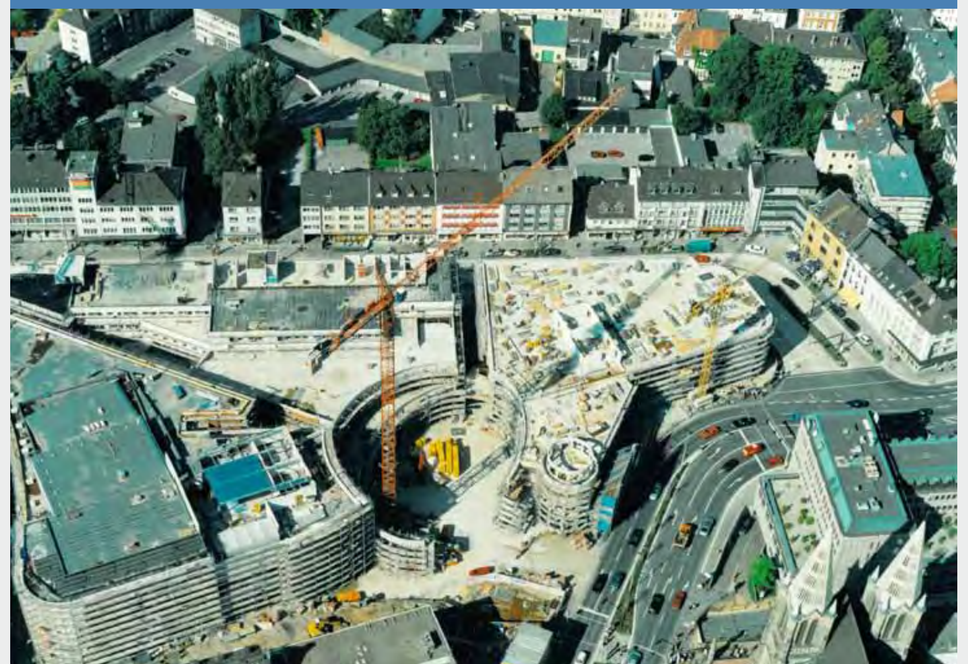
Ab September 1998 floss der Durchgangsverkehr auf der Goerdelerstraße als neuer Nord-Süd-Achse der Innenstadt. Am 27. April 2000 wurden die Clemens-Galerien von Oberbürgermeister Franz Haug eröffnet.
