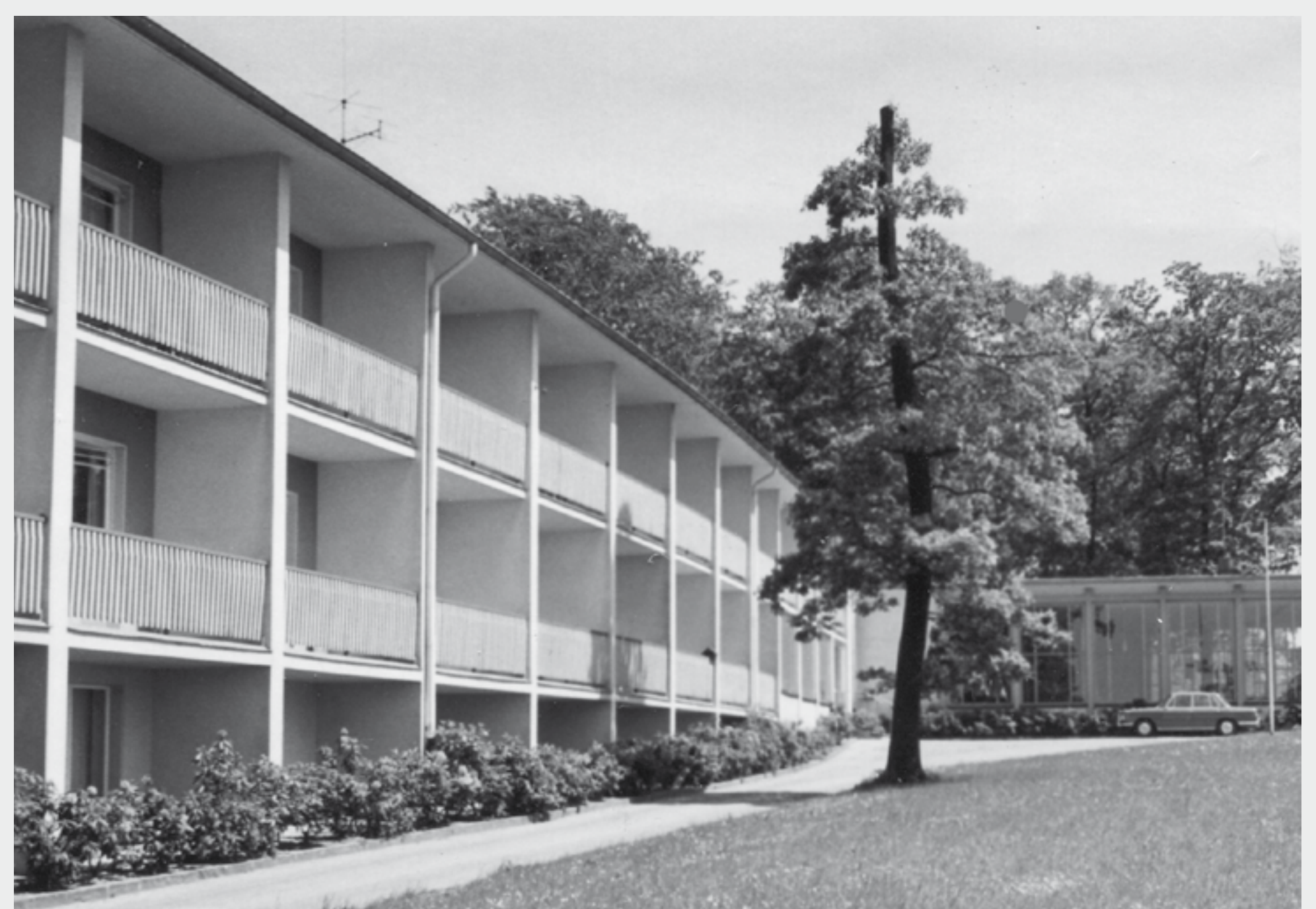
Das „Eugen-Maurer-Heim“ im Gräfrather Stadtwald wurde 1960 seiner Bestimmung übergeben. Mit 180 Heimplätzen war es nicht nur das größte Solinger Altersheim seiner Zeit, es war auch das erste speziell für diesen Zweck errichtete städtische Gebäude.
