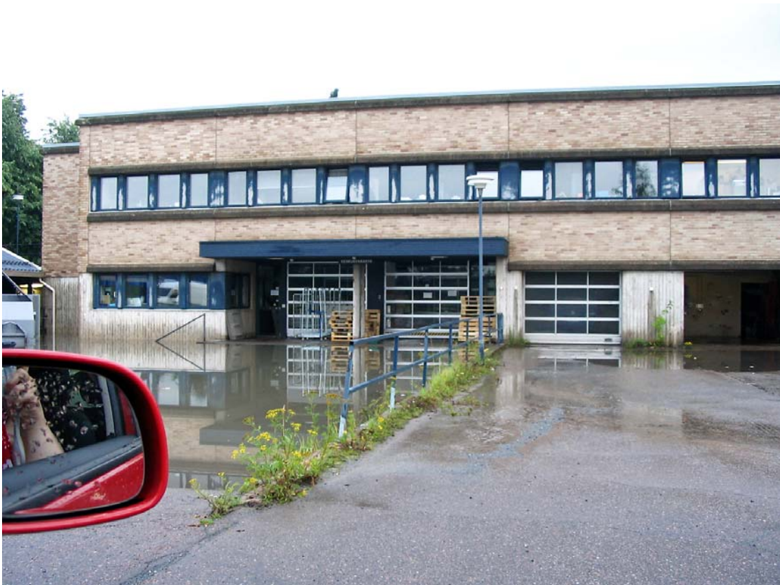
Kaupunginsairaalan pohjoissivulla vesi on täyttänyt ajoluiskan Kuva: 12.8.2007 klo 20.17 Tuomo Piippo
