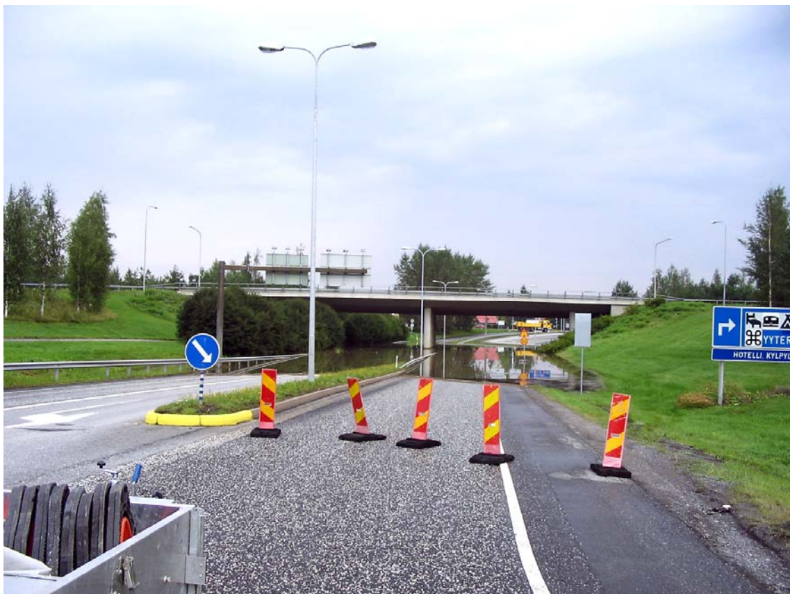
Valtatie 8:n alikulku valtatie 2:n kohdalla on poikki vielä seuraavana päivänä Kuva: 13.8.2007 klo 12.14 Tuomo Piippo
