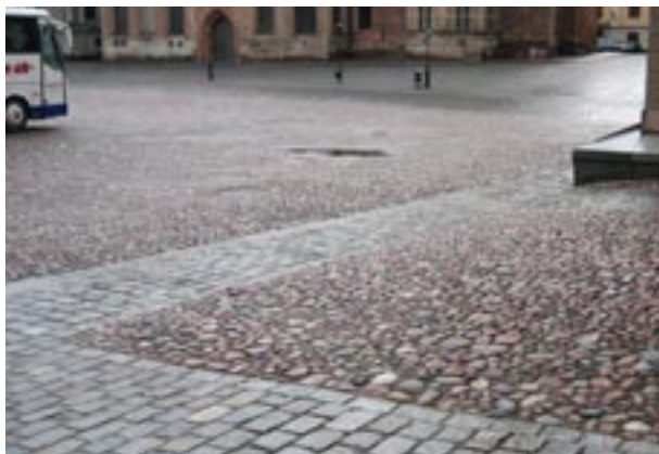
Foto av beläggningen på Birger Jarls torg. Kullersten genomkorsas här och var av stråk av storgatsten för att underlätta för gående.
