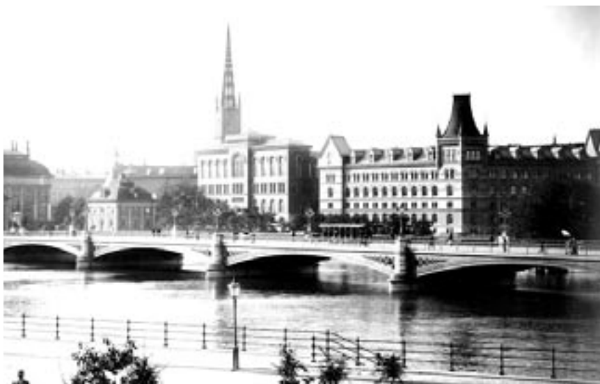
Foto från 1896. I förgrunden Vasabron, därbakom Norstedts och Riksarkivets nya byggnader som helt förändrade vyn mot Riddarholmen från Norrmalm.
