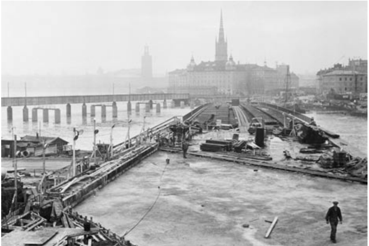
Foto av tunnelbanan och Centralbron under uppförande 1956.
