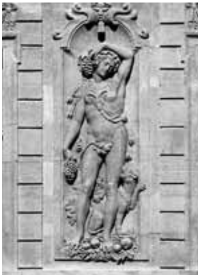
Hôtel de Sully, façade après restauration
