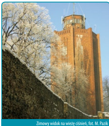
Zimowy widok na wieżę ciśnień, fot. M. Pazik
