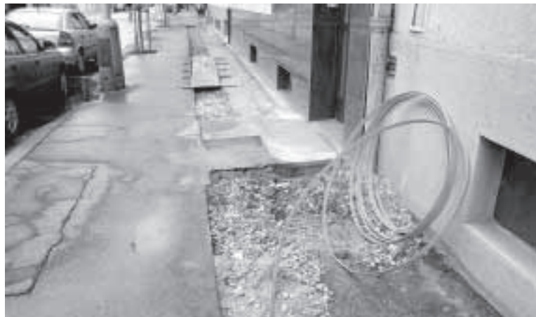
Na Námestí SNP vymieňajú elektrické rozvody. Foto: just
