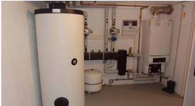
Eine neue Heizungsanlage gehört genau so zum Energieeinsparparkonzept im sanierten Haus „Zum Sünfzen“ wie eine Wärmerückgewinnungsanlage, die hilft, die Abwärme der Kühlmaschinen für die Aufbereitung von ca. 1.000 Liter Warmwasser pro Tag zu nutzen. BZ-Fotos: Steiger Partner
