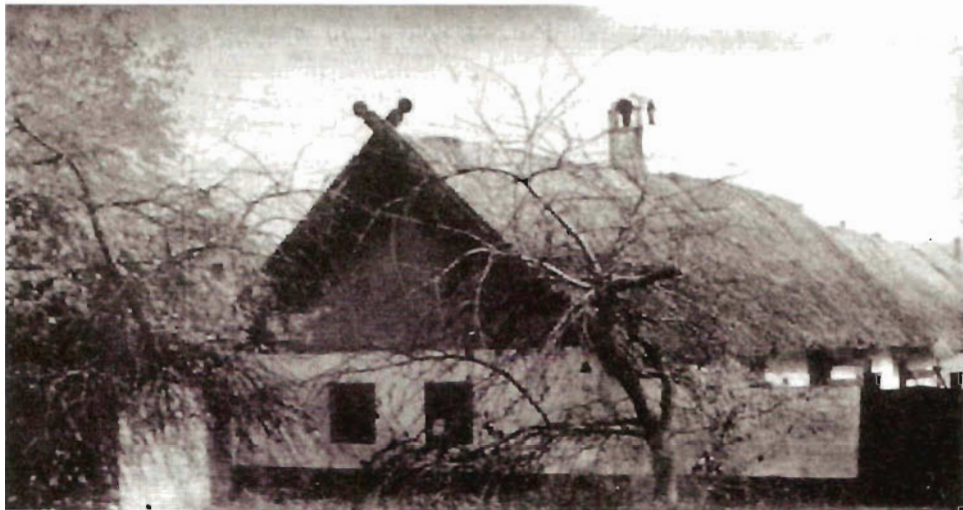
4. ábra: Vertfalú ház nádtetővel és széldeszékával. Építési ideje a 19. sz. közepe (fotó: Végvári)
