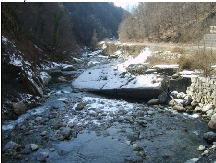
Épi basculé à la suite d'un affouillement local
