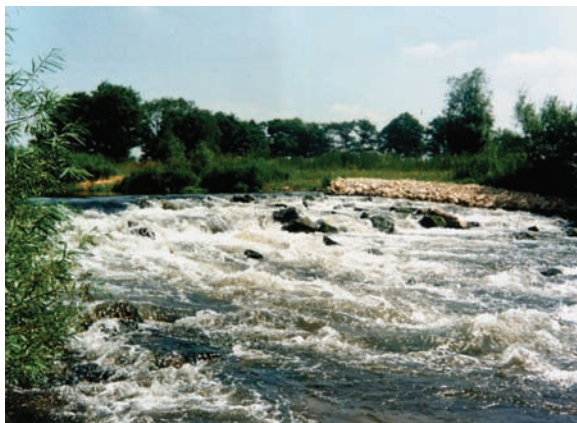
Fot. 13. Przykład sztucznego bystrza z głazów
