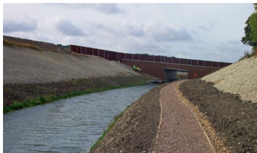
Fot. 7 i 8. Przykłady spoza Polski. Obniżenie ciągu pieszego biegnącego wzdłuż rzeki do poziomu średniej wody pozwoliło znacznie zwiększyć szerokość koryta, a przez to zmniejszyć prędkości wód wezbraniowych. Obecność roślinności strefy ziemno-wodnej (prawe zdjęcie) dowodzi, że prędkości przepływu umożliwiają ich egzystencję (©Arup)
