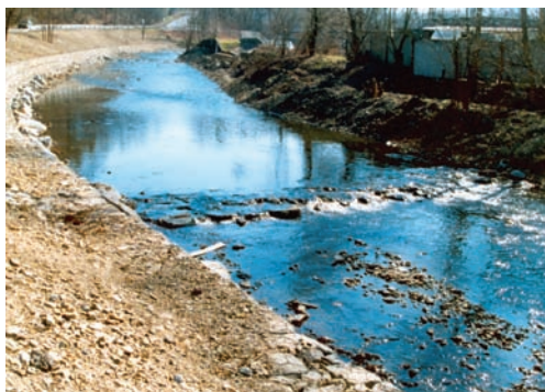
Fot. 9. Sposób zakończenia narzutu na skarpie: narzut zakończony konstrukcją poprzeczną poprowadzoną w kierunku przeciwnego brzegu
