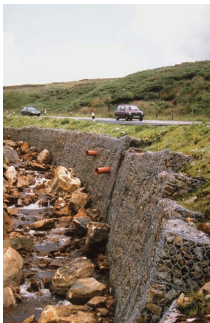
Fot. 4. Przykład spoza Polski. Ochrona lokalna fragmentu pasa drogowego. Zachowany pas ekotonu przy drodze (min. 2 m dla celów utrzymania jakości wody). Przed gabionami widoczne umocnienie dna ciekę znacznie grubsze niż by to wynikało z oszacowań, dla trwałego ustabilizowania przekroju w sąsiedztwie drogi (©Arup)
