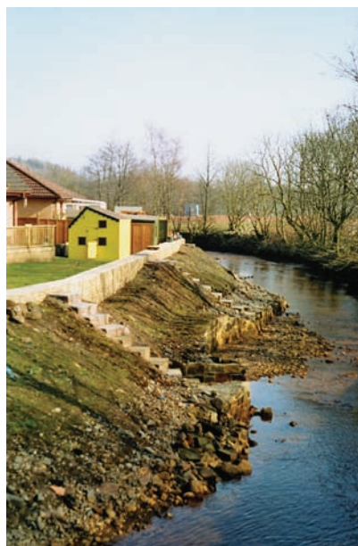
Fot. 5 i 6. Przykłady spoza Polski. Osłona przeciwpowodziowa terenów zamieszkałych kompensowana rozległą terasą zalewową na przeciwnym brzegu rzeki. Umocnienia brzegów rzeki urządzone w sposób umożliwiający ich zasiedlenie przez roślinność strefy ziemno-wodnej. Rzeka nie sprawia wrażenia odcięcia od przyległych terenów, przeciwnie, rozwiązania techniczne sprzyjają umożliwieniu dostępu do rzeki (©Arup)
