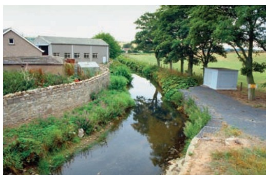
Fot. 5 i 6. Przykłady spoza Polski. Osłona przeciwpowodziowa terenów zamieszkałych kompensowana rozległą terasą zalewową na przeciwnym brzegu rzeki. Umocnienia brzegów rzeki urządzone w sposób umożliwiający ich zasiedlenie przez roślinność strefy ziemno-wodnej. Rzeka nie sprawia wrażenia odcięcia od przyległych terenów, przeciwnie, rozwiązania techniczne sprzyjają umożliwieniu dostępu do rzeki (©Arup)
