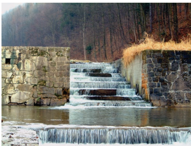
Fot. 3. Przepławka na potoku Wierchomla
